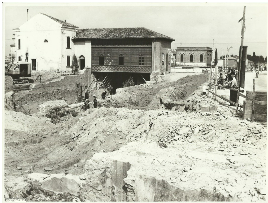
Demolizioni muri di sostegno mandracchio
