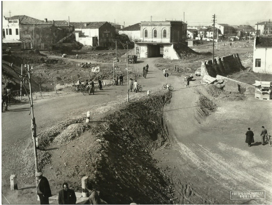
Opere di demolizione contro sostegno Polesella
