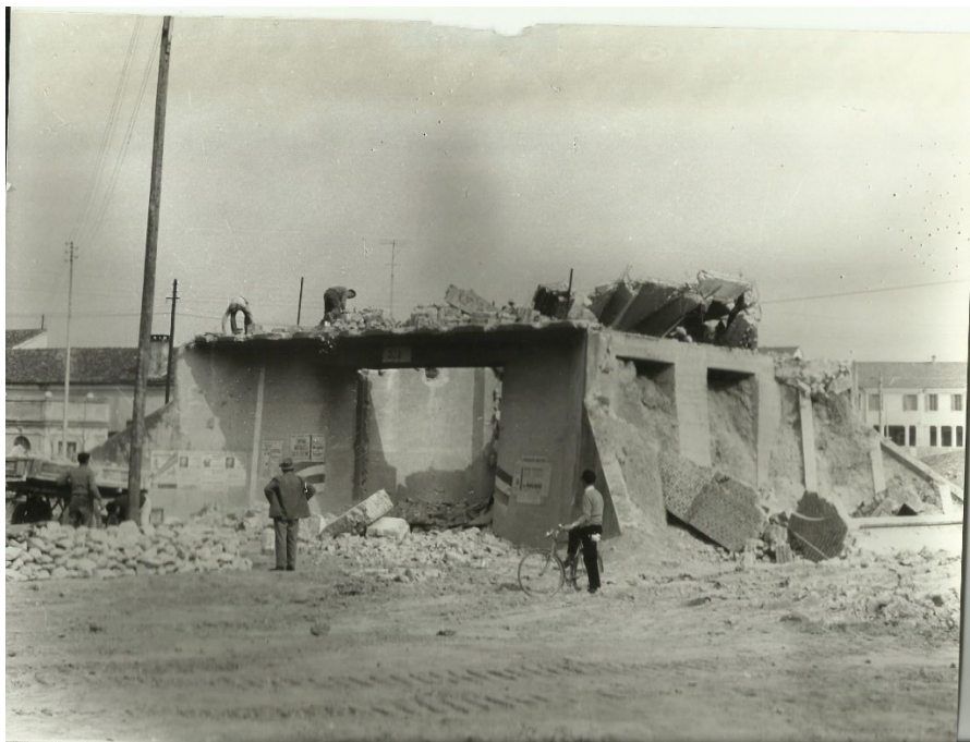
Demolizione contro sostegno
