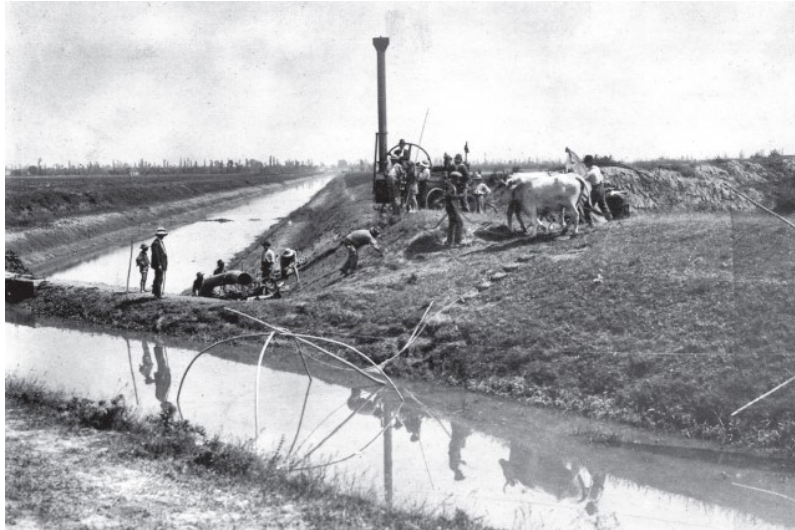
Opere di bonifica
