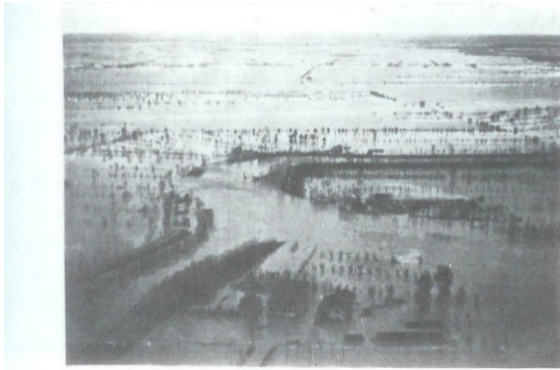
Veduta aerea delle breccie verificatesi alle arginature della Fossa Polesella.
