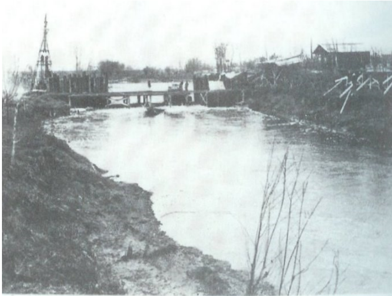
Lavori in corso per lo sbarramento provvisorio della Fossa Polesella.
