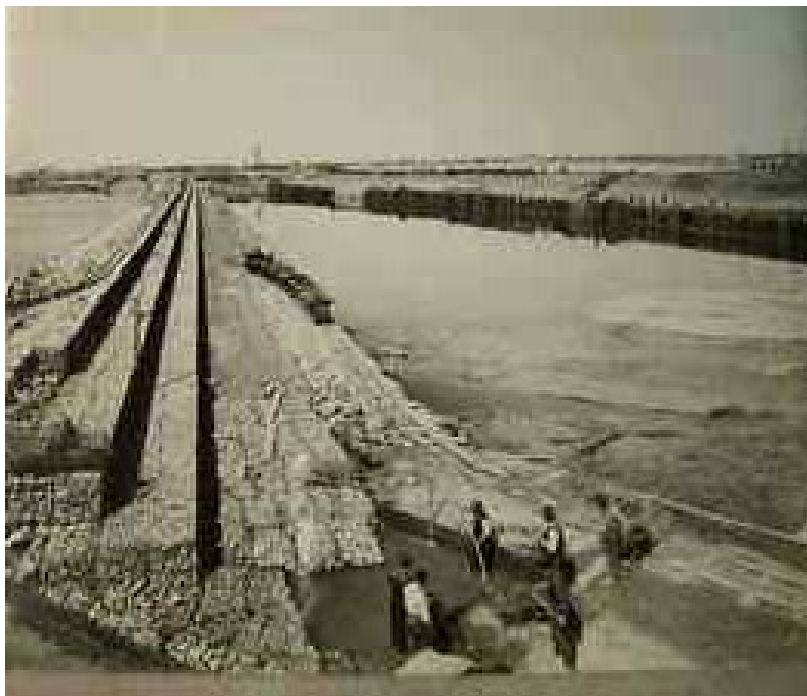
Opere di bonifica
