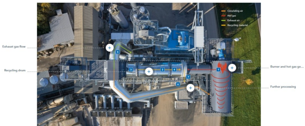
Figura 2.18: Schema impianto Benninghoven.
