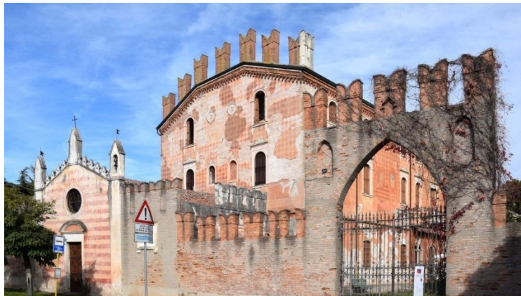
Figura 35: Villa Miari de Cumani a Sant'Elena. Presa dal sito Ciclo culturando
