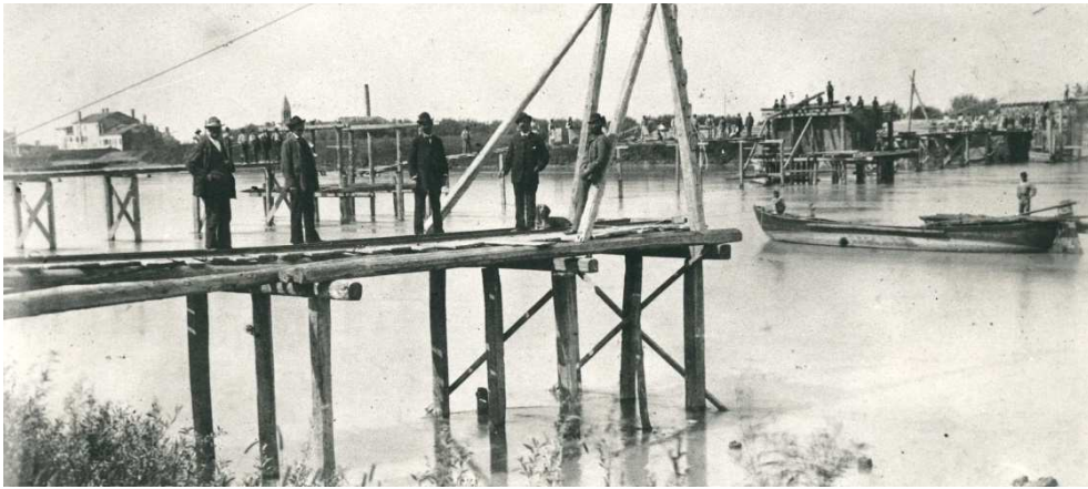
Figura 38. Cavanella d'Adige: costruzione del ponte ferroviario a fine Ottocento. Fonte: Museo Civico della Navigazione Fluviale di Battaglia terme, PD.
