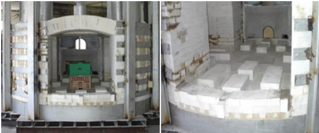
Figura 57 - Forno a crogiolo, vista frontale e interna in fase di costruzione (fonte Falorni s.r.l.)
