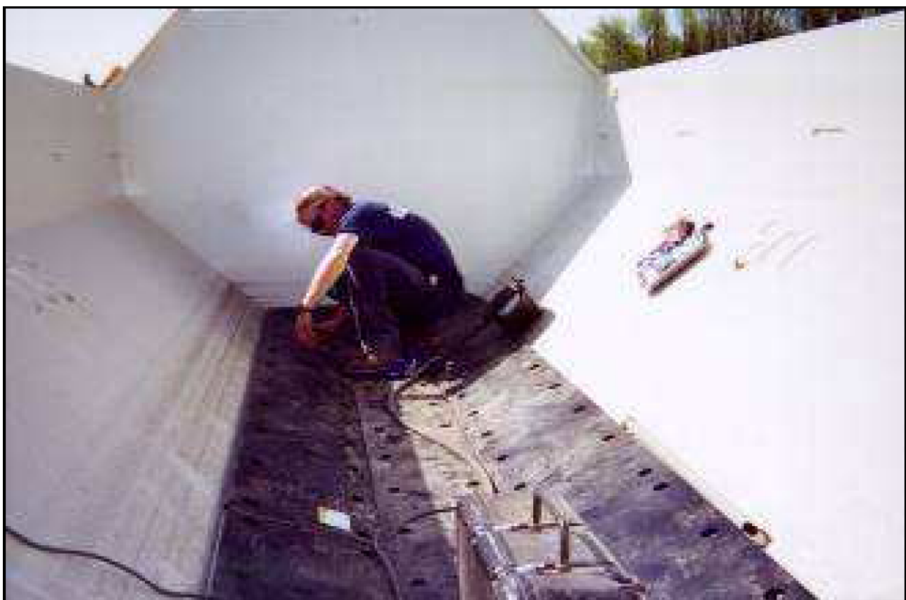
Figura 4.4 applicazione in opera del rivestimento in Tivar®88.
