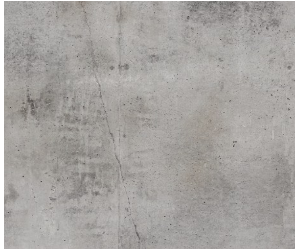
Fig.5.3: il calcestruzzo a vista lisciato strutturale
