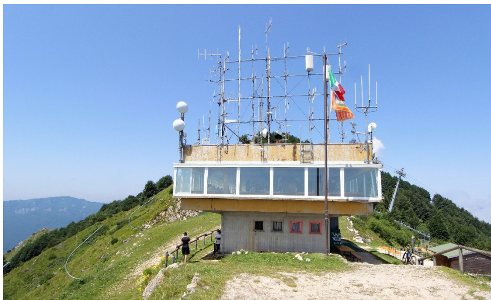
Fig.3.11: le invadenti antenne installate sulla copertura
