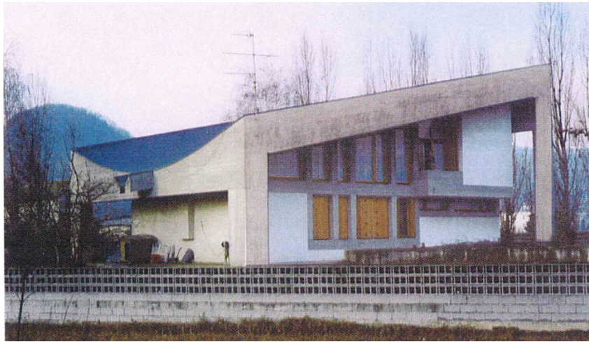
Fig.3.5:Casa Michelin, Cornedo, Architetto Giorgio Guasina 19
