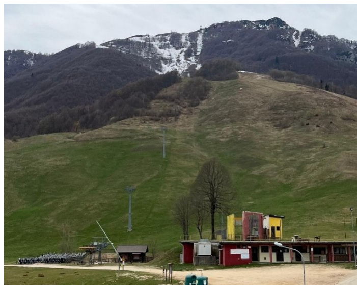
Fig.3.2:la stazione a valle della seggiovia dismessa Recoaro Mille-Montefalcone
