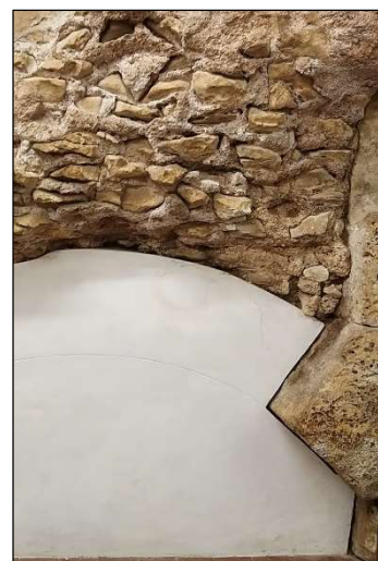
Figura 3.7. Caementa del muro con arcate del criptoportico. Foto Autore.
