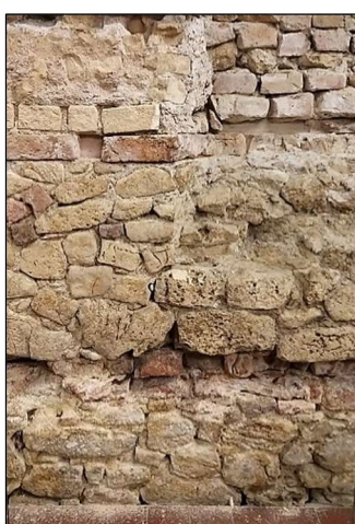
Figura 3.9. Un tratto del muro continuo del criptoportico. Foto Autore.
