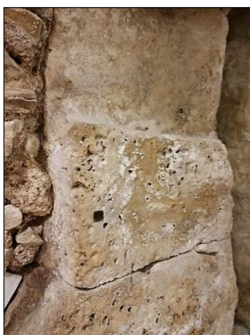
Figura 3.8. Pilastro a grandi blocchi di calcare tra le arcate. Foto Autore.
