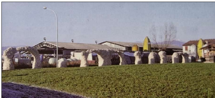
Figura 1.3. Alcune arcate e piloni dell'acquedotto di Vicenza, in località Lobia. Fonte: MATTIELLO 2012, p. 129.
