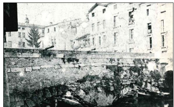
Figura 3.3. Il ponte San Paolo prima della demolizione nel 1875. Fonte: MARCHINI 1979, fig. 16.
