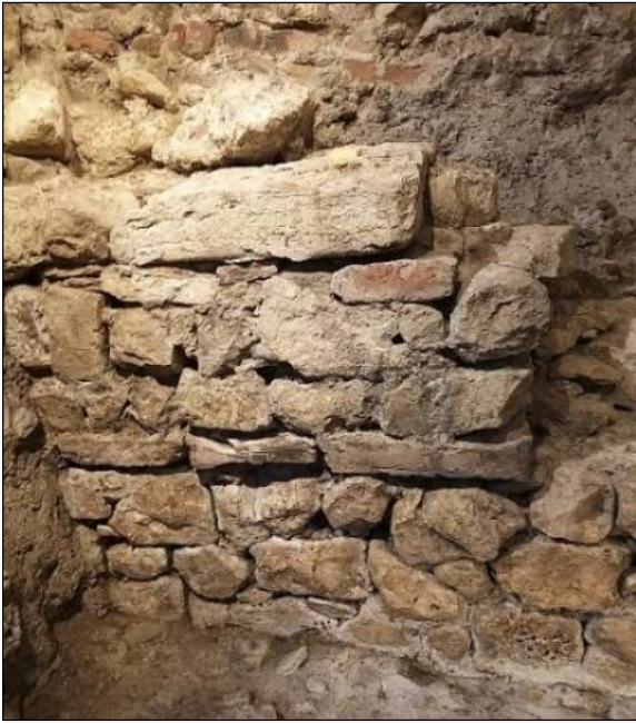
Figura 3.54. Tratto di fondazione dell'edificio 1, con corsi di blocchetti lapidei misti a corsi di laterizi. Foto Autore.
