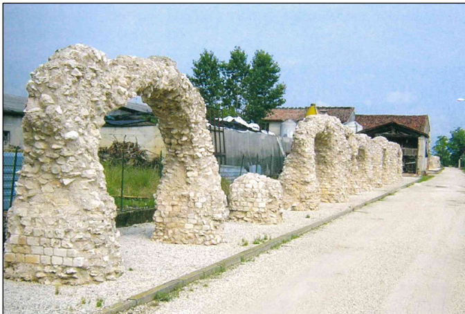
Figura 3.15. Alcune delle arcate dell'acquedotto romano in località Lobia. Fonte: CATTELAN 2007, p. 17.
