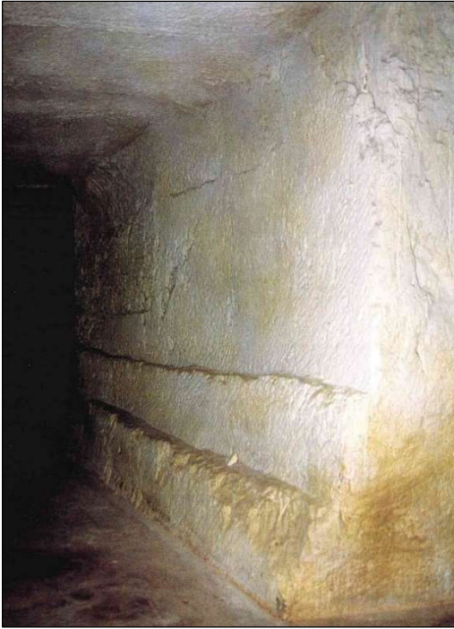
Figura 2.13. Esempio di gradoni creati all'interno della cava dall'attività estrattiva (interno del Covolo della Guerra a Costozza di Longare). Fonte: BUONOPANE 1987, p. 200.
