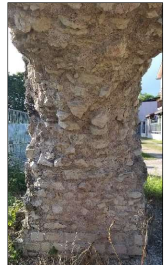
Figura 3.20. Loc. Lobia: pilastro della zona Nord in cui l’ opus vittatum inizia da terra. Foto Autore.
