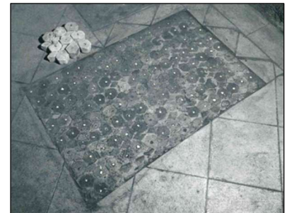
Figura 3.48. Pavimento con esagonelle in cotto e tessera bianca al centro, della prima fase. Fonte: FORLATI TAMARO 1958.
