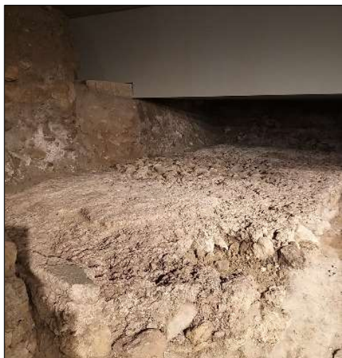
Figura 3.57. Livelli di preparazione del pavimento dell'edificio 2. Foto Autore.
