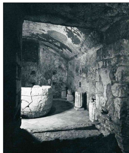
Figura 3.43. Ambiente Nord-Ovest con finestrella e soglia rialzata. All'interno alcuni rocchi di colonna ritrovati durante lo sterro. Fonte: FORLATI TAMARO 1958.
