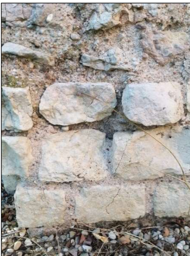
Figura 3.18. Loc. Lobia: dettaglio di paramento in blocchetti e nucleo di un pilastro. Ben visibile il colore della malta ricca di inclusi laterizi. Foto Autore.
