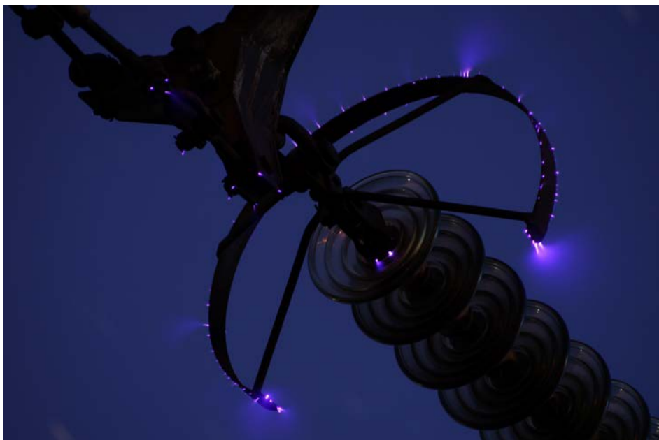
Fig. 2-17 Il fenomeno corona sugli armamenti di un elettrodotto in alta tensione (fonte: wikimedia)
