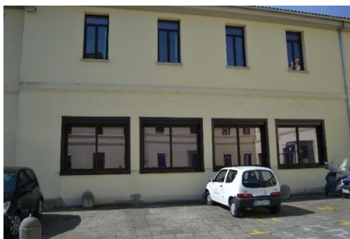
Figura 5.18 Aperture parzialmente tamponate, vecchi garage delle autobotti
