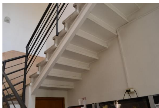
Figura 5.27 Scala con struttura portante in acciaio
