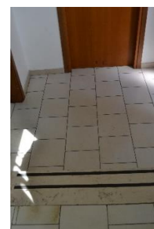
Figura 3.30 Differenza di quota tra solai
