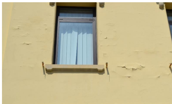
Figura 5.63 Rigonfiamento-prospetto 4
