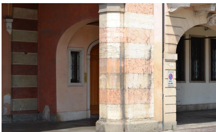
Figura 5.60 Macchia scura-prospetto Loggia1
