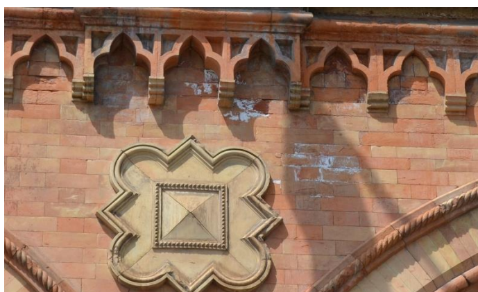
Figura 5.58 Efflorescenza-prospetto Loggia1
