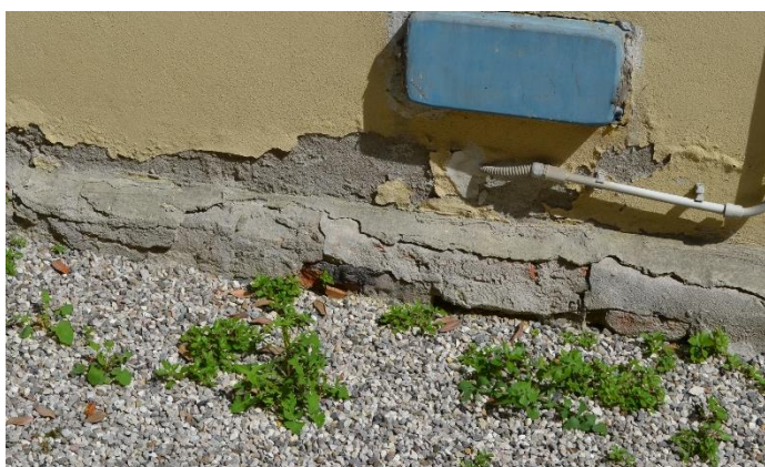
Figura 5.64 Scagliatura-prospetto 3b
