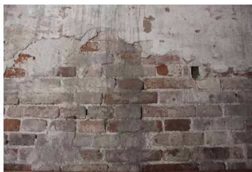
Figura 5.07 Tessitura muraria, sottoscala
