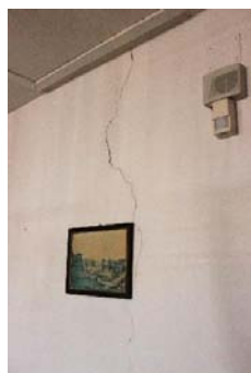
Figura 5.46 Fessura profonda
