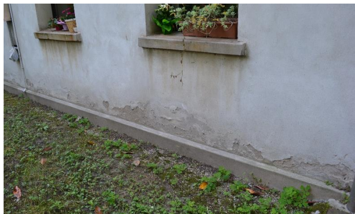
Figura 5.55 Colatura-prospetto 8b
