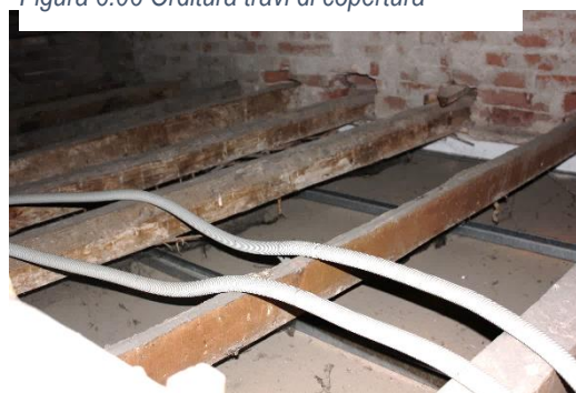
Figura 6.06 Orditura travi di copertura
