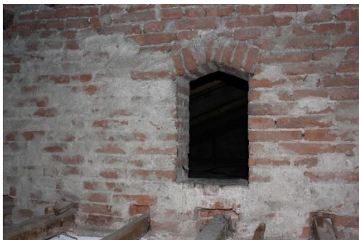
Figura 5.12 Tessitura muraria, sottotetto
