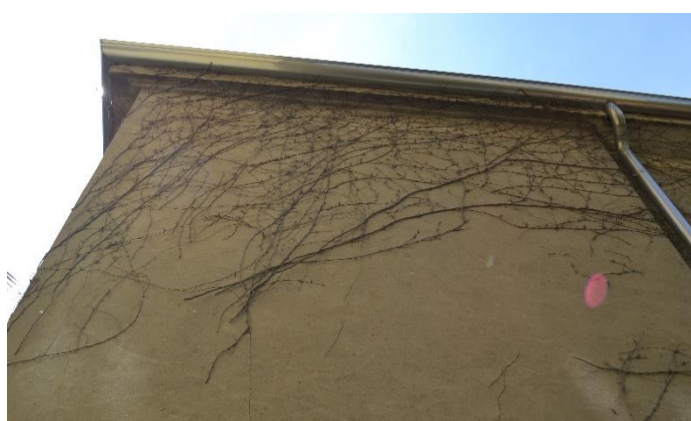
Figura 5.62 Presenza di vegetazione-prospetto 8b
