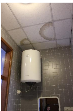
Figura 5.50 Infiltrazioni
