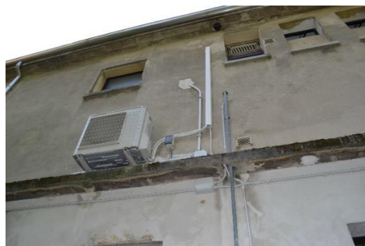
Figura 5.76 Unità esterna del sistema di condizionamento
