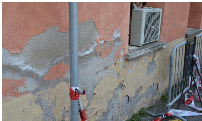
Figura 5.57 Distacco-prospetto Loggia2
