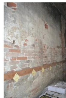
Figura 3.22 Muratura d'ambito del deposito sotto lo scalone
