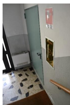
Figura 5.76 Porta REI e manichetta dell'idrante
