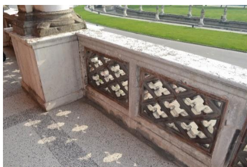
Figura 5.40 Degrado parapetto
