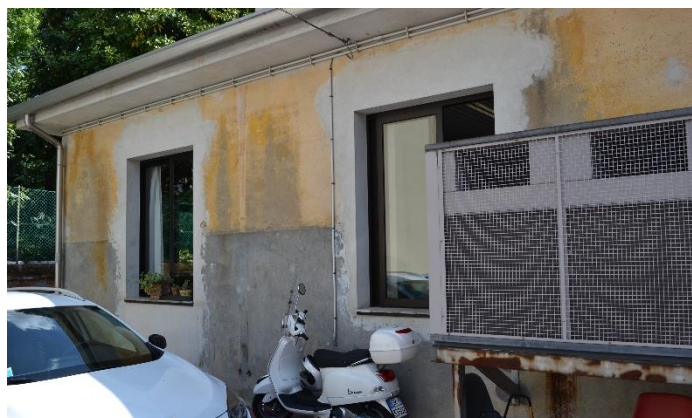
Figura 5.56 Degrado diffuso-prospetto 5
