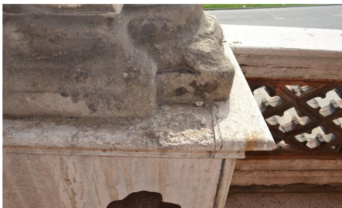
Figura 5.59 Erosione-prospetto Loggia1
