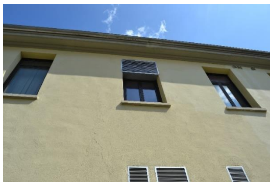
Figura 5.75 Prese d'aria nello spessore della muratura
