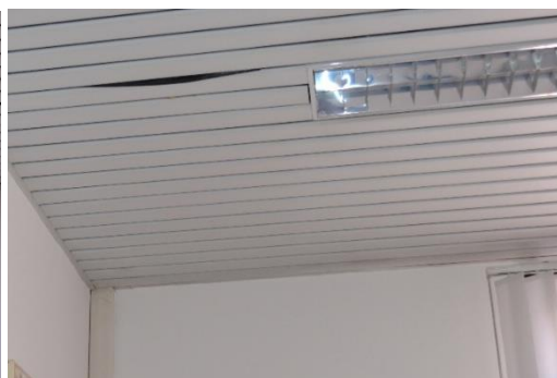
Figura 5.71 Inflexione del controsoffitto
