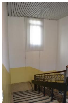
Figura 3.28 Scala blocco sud
