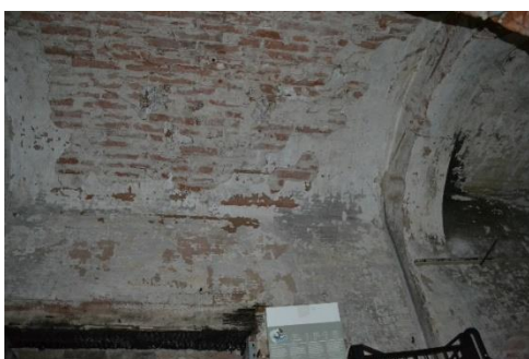
Figura 3.23 Copertura voltata sotto il pianerottolo
