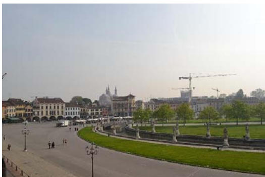
Figura 3.19 vista su Prato della Valle
