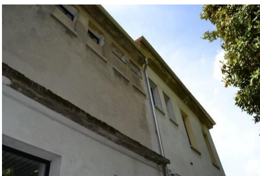
Figura 5.26 Maschi murari di ridotte dimensioni
