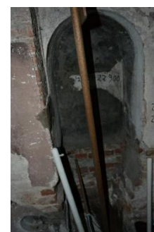
Figura 3.25 Apertura tamponata
