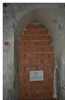
Figura 3.24 Apertura tamponata
