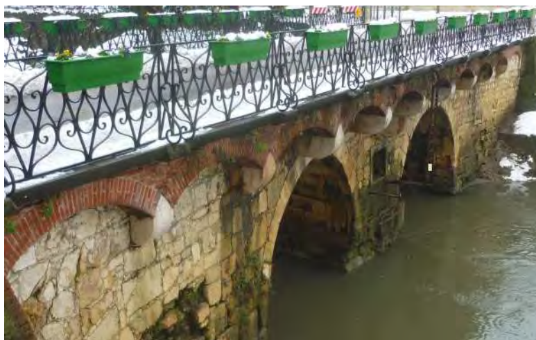
Figura 4.28 : Ponte Furo, Vicenza
