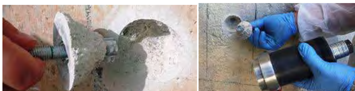
Fig. 2.10: Prova di pull -out
