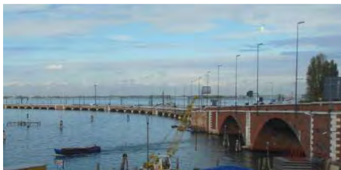
Figura 4.37 : Ponte della Libertà, Venezia
