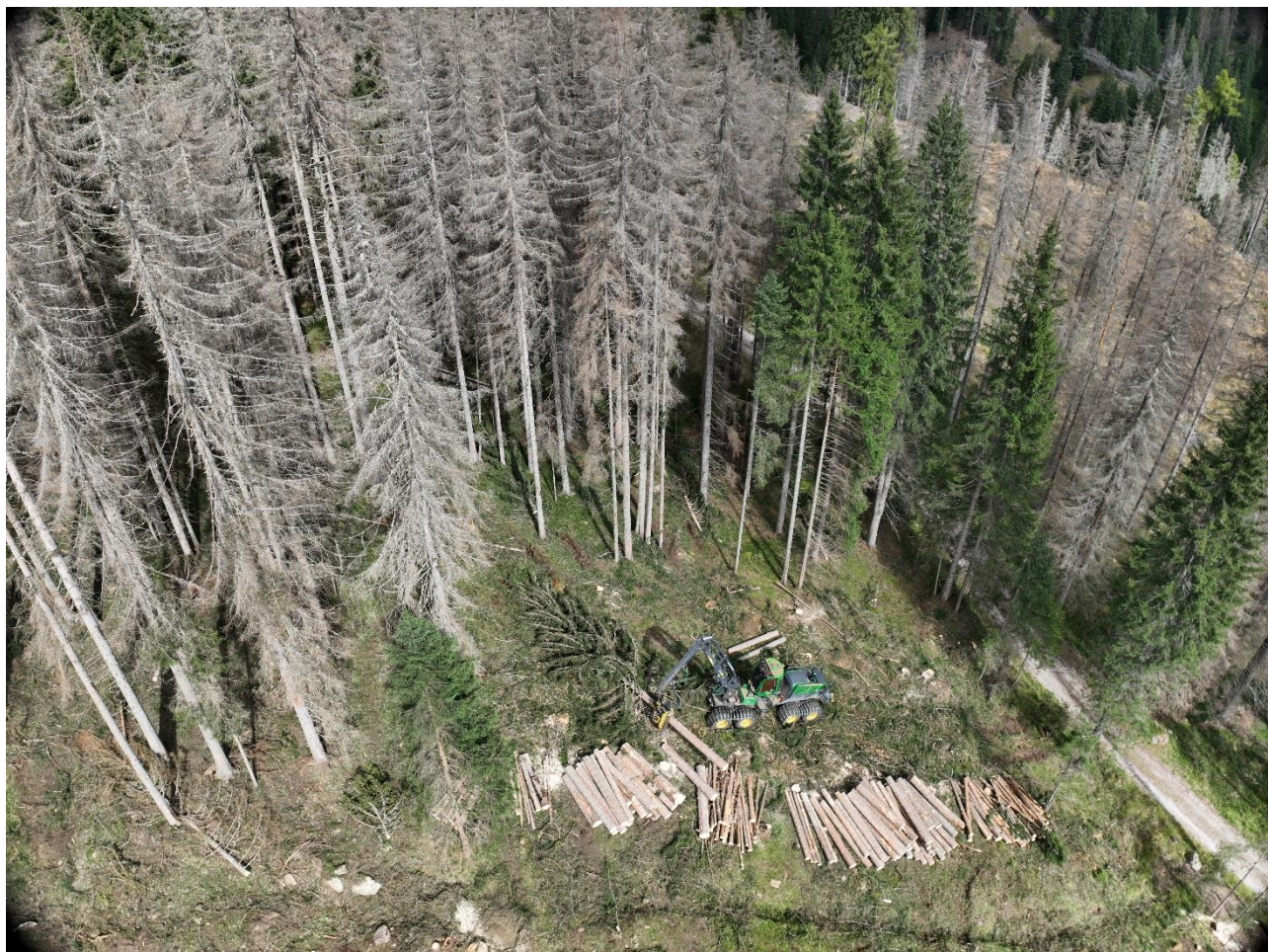
Figura 5: foto drone del cantiere La Rovina di Paneveggio, harvester in opera, presenza di piante bostricate.
