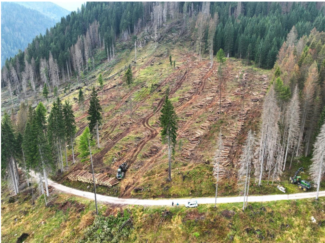
Figura 16: immagine drone del cantiere in fase di svolgimento, si notano entrambe le macchine operanti e zone in cui sono ancora presenti piante morte in piedi.
