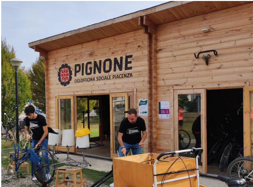
Immagine 11. Vista esterna dell'edificio costruito per la ciclofficina
