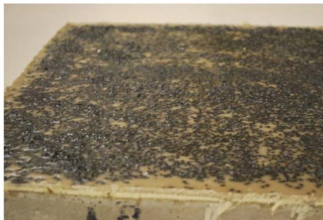
Figura 4.7 Esempio di pavimentazione realizzata con tecnica slurry
