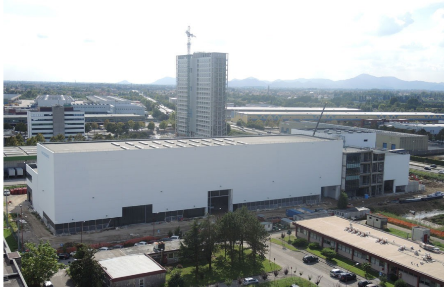
Figura 2.1 Foto aerea della struttura PRIMA presso Padova.
