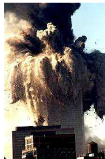
Figura 29: Crollo Torre Nord.
