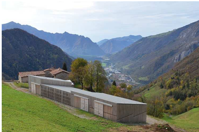
Figura 2.4 visione della stalla e la parte del fienile sulla destra dell'edificio con i portoni di accesso per lo scarico del fieno
