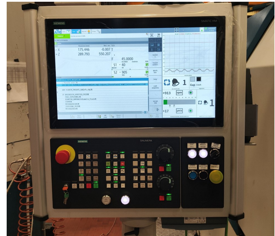
Pulpito dopo l'intervento
