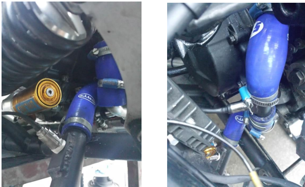
Fig. 11 : Sensori di pressione installati in macchina ( sx: aspirazione – dx: mandata)
