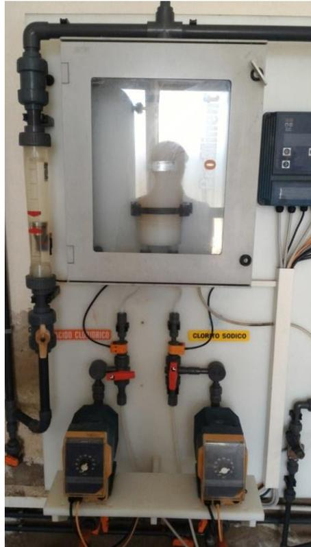
Figura 11. Pompe volumetriche di alimento del reattore di biossido di Cloro
