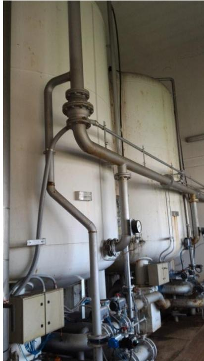
*Figura 5. Potabilizzatore Ferro e Manganese*
