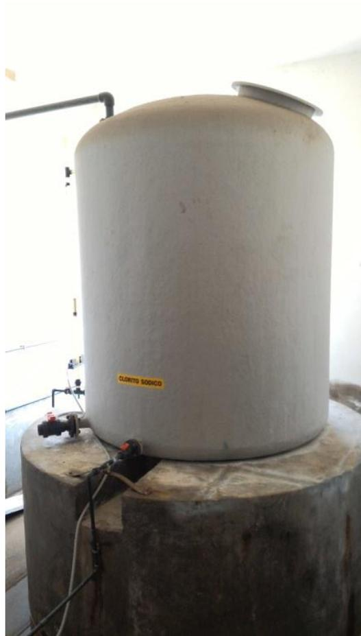
*Figura 10. Serbatoio Ipoclorito di Sodio*
