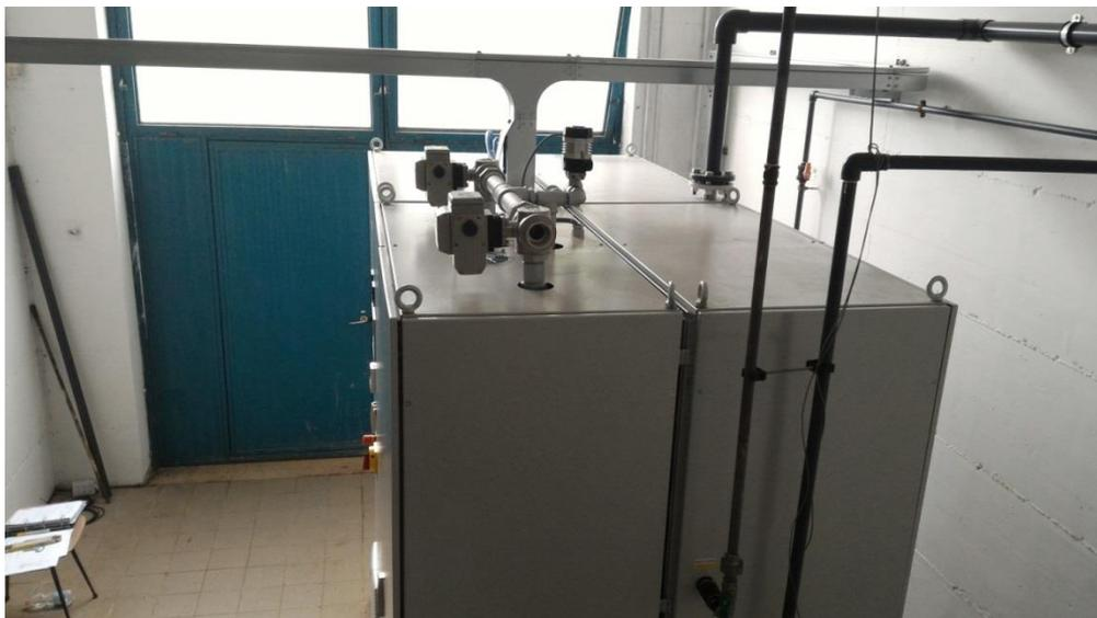
*Figura 13. Apparecchiatura per l'aggiunta di Ozono*
