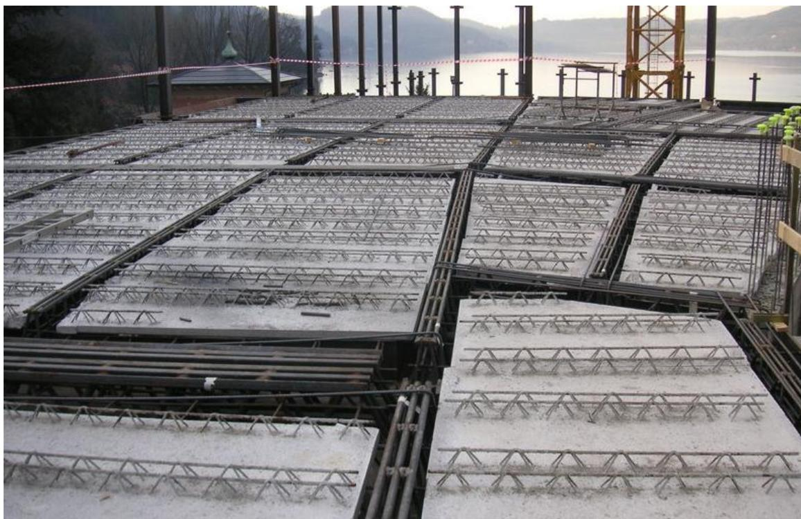
*Fig2.5 Foto Cantiere "Impalcato Pronto per il Getto di Completamento".*
