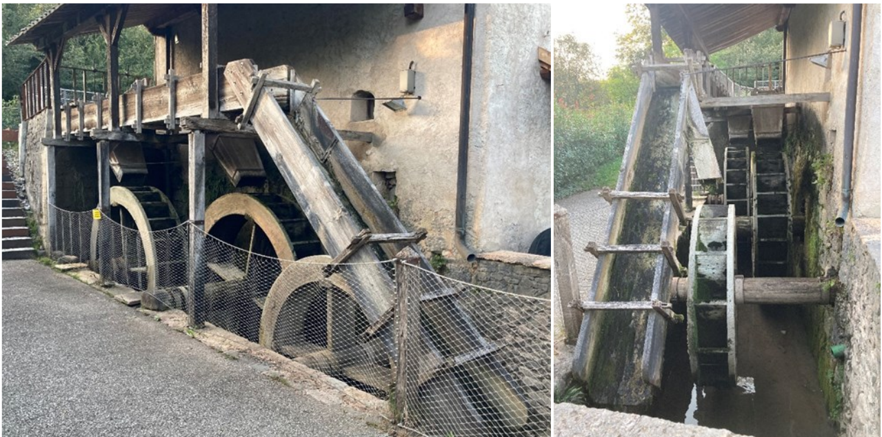
Figura 32. Nelle due immagini si vedono chiaramente le tre ruote a coppedello e le canalette in legno che ne trasportano l'acqua. Mulino di Santa Libera, Santa Giustina. Foto dell'autore.
