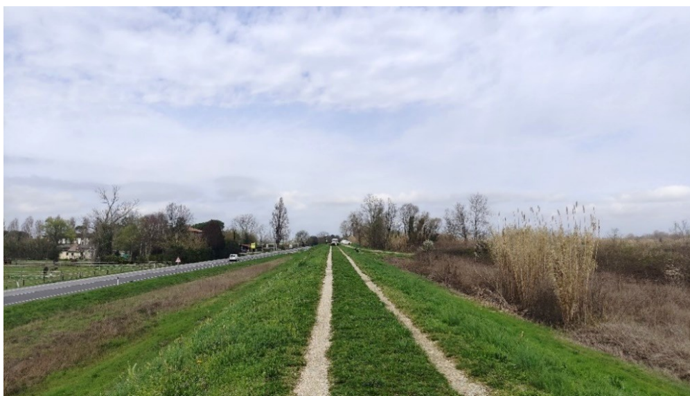
Figura 35 - Vista S-N del sito. È possibile notare la vicinanza della via di comunicazione all'alveo
