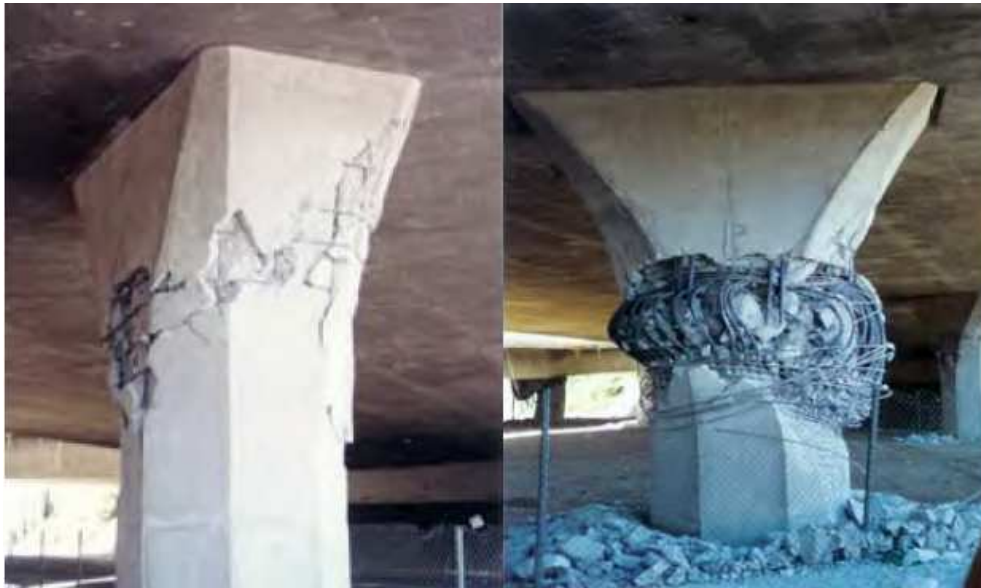
Fig. 1.3 Esempio di rottura a taglio di pile di ponti stradali, terremoto di Northridge, USA 1994
