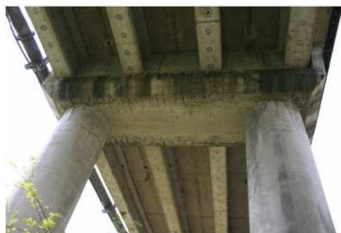
Fig. 6.1 Viste della struttura a telaio delle pile del ponte di Fener, Alano di Piave (TV)
