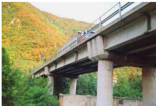
Fig. 5.4 Vista delle pile del ponte di Fener
