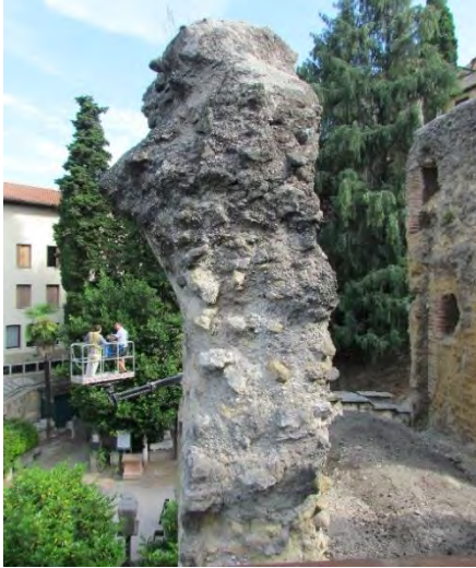
Fig. 4.49 – Foto del Setto A3, particolare del nucleo a sacco della muratura.
