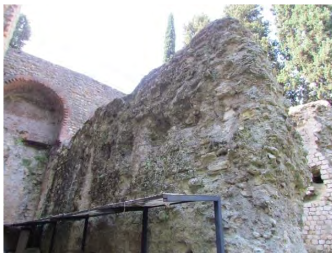
Fig. 4.14 – Vista del setto A2
