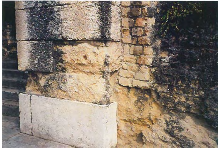
Fig. 4.38 – Muro del teatro con ampie zone di distacco, estese lacune nel lapideo, oltre ad ampie croste nere
