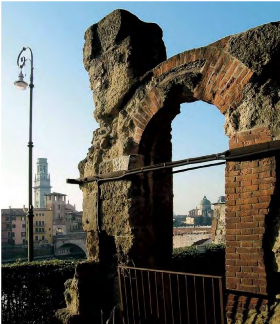
Fig. 1.44– Teatro Romano Consolidamento dei ruderi e ancoraggi, Ufficio Tecnico del Comune di Verona, foto 1986
