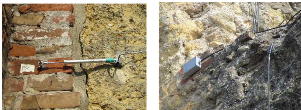
Fig. 9.12 e 9.13 – Potenziometro posizionato sull'arco d'ingresso del Teatro e inclinometro sul setto B3
