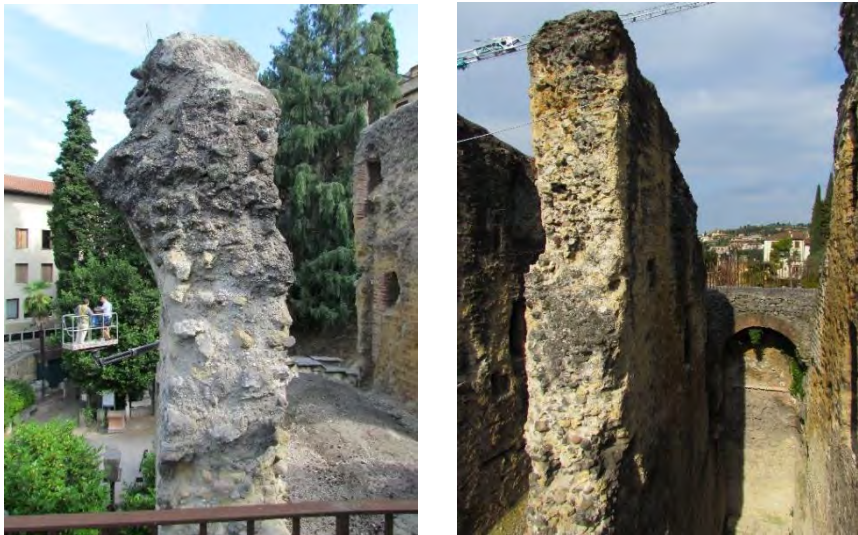
Fig. 1.12 – 1.13 Vista della sezione rispettivamente del setto A3 della zona museo e del setto B2 della zona chiesa
