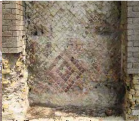
Fig. 1.8 – Passeggiata superiore, opus reticulatum
