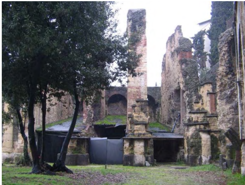
Fig. 1.26 – I muri radiali a sostegno della cavea nel settore orientale, foto
