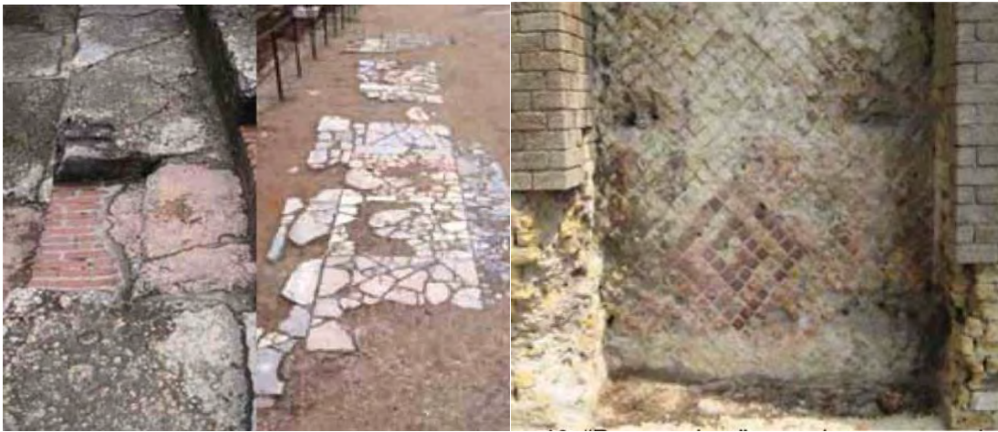
Fig. 1.7 – Pavimento in opus sectile dell'orchestra, ricostruito o integralmente creato agli inizi del 900
