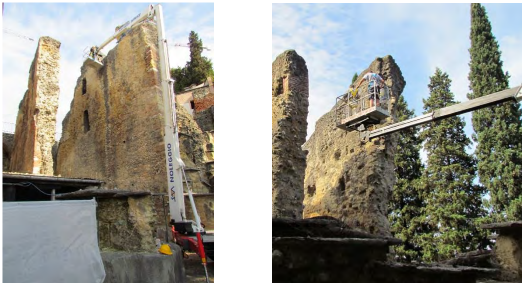
Fig. 9.15 - Posizionamento dei sensori tramite piattaforma aerea
