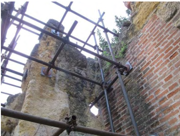
Fig. 4.51 e 4.52 – Porzione di scena puntellata e porzione di scena con tiranti
