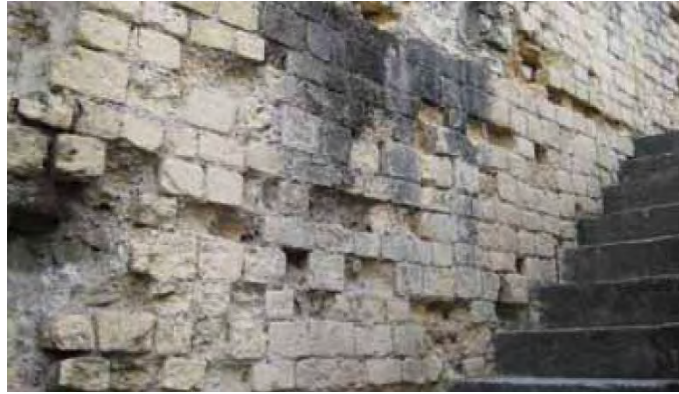
Fig. 1.6 – Scalinata del teatro, esempio di opus vittatum
