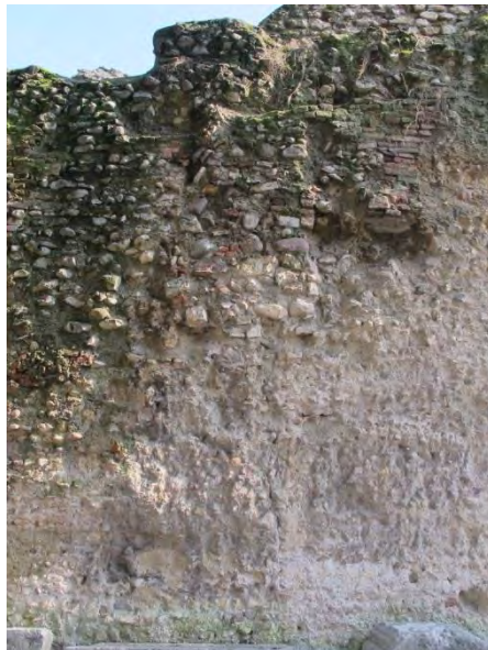
Fig. 4.43 – Macchia sul setto della zona Museo dovuta principalmente a sostanze organiche
