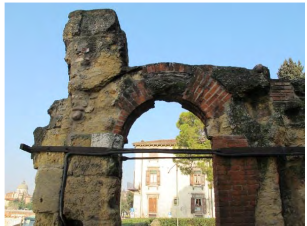
Fig. 4.51 e 4.52 – Porzione di scena puntellata e porzione di scena con tiranti
