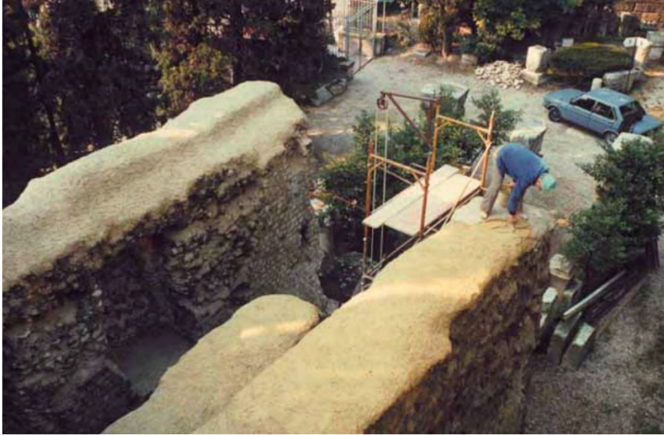
Fig. 1.43– Teatro Romano protezione orizzontale dei ruderi, Ufficio Tecnico del Comune di Verona, foto 1986
