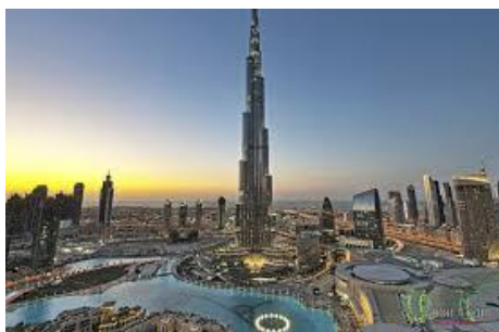
Figura 1.5 - L'efficienza dell'impianto idraulico del Burj Khalifa di Dubai è garantita da pompe marchiate Xylem.
