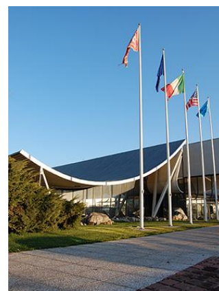
Figura 1.2 - Ingresso dello stabilimento.
