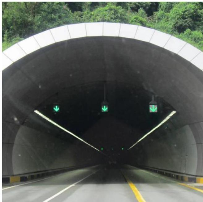
*Figura 53: Semaforo segnalante lo stato di servizio di ciascuna carreggiata della galleria. Alibaba*
