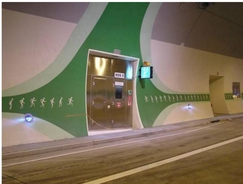
*Figura 50: Esempio di via d'esodo che conduce ad un "Armadio di soccorso", ossia ad un rifugio sicuro.*
