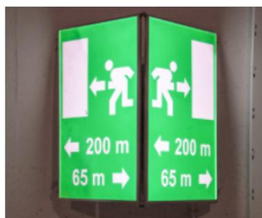
Figura 52: Esempio di cartello indicante le uscite di emergenza presenti in galleria. Tecnotun
