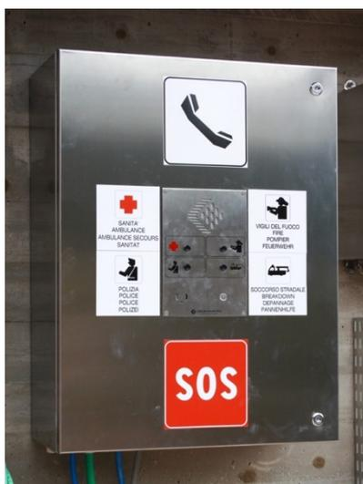
Figura 57: Esempio di apparecchio telefonico di soccorso da galleria stradale polivalente. Tecnotun
