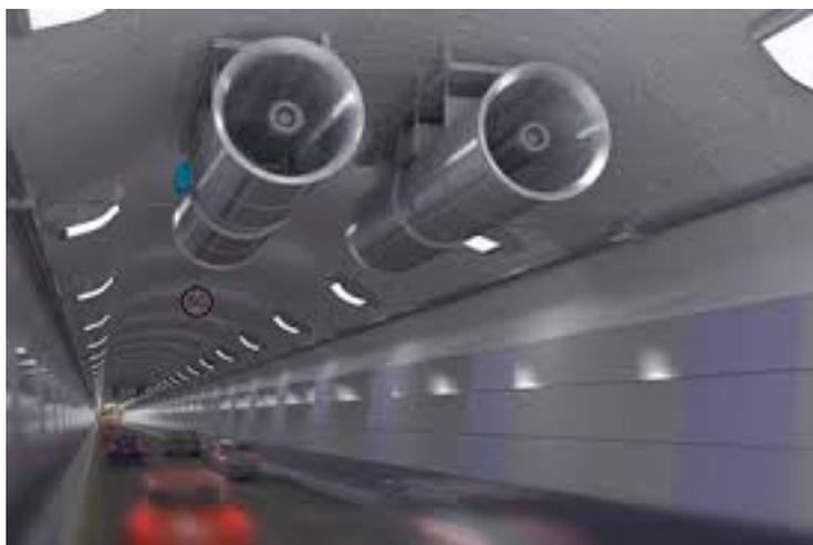
*Figura 44: Coppia di Jet Fan installati in una galleria. FlaktGroup*
