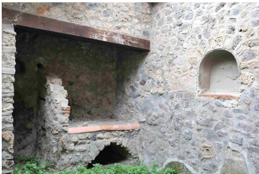
Fig. 16-Pompei, Casa con officina (I 10, 1), nicchia-parete nord, 2018 (da Pompeiinpictures).
