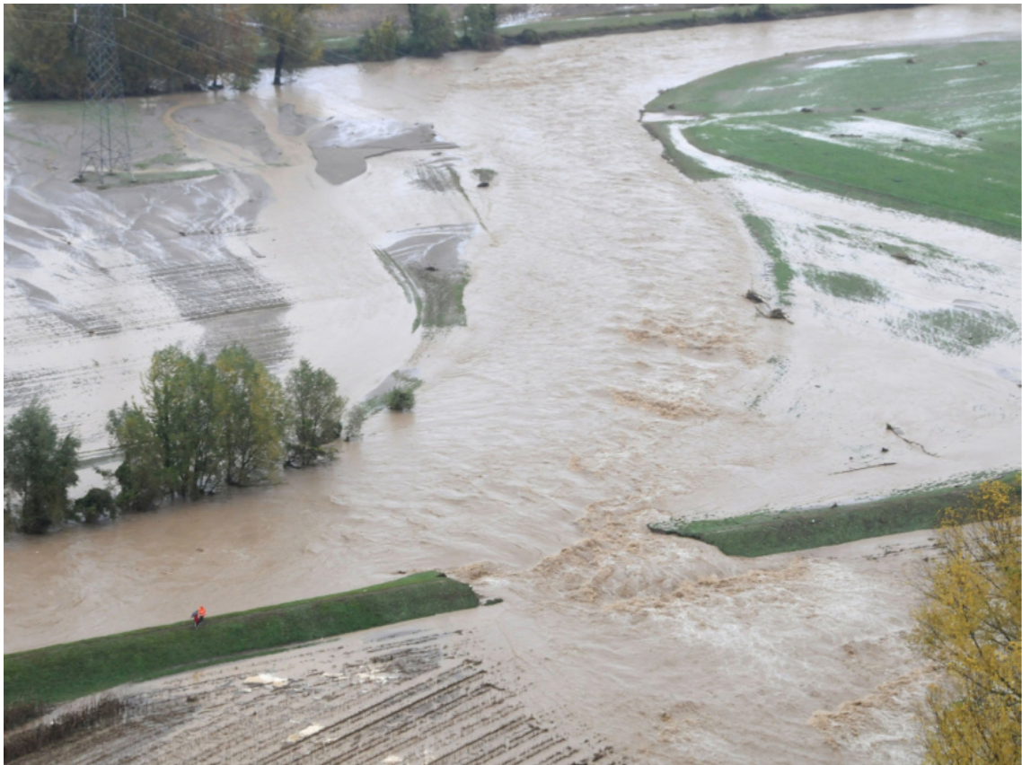
Figura 2.9: Esondazione del Timonchio nel novembre 2010 con rottura degli argini nel comune di Caldogno (VI).
