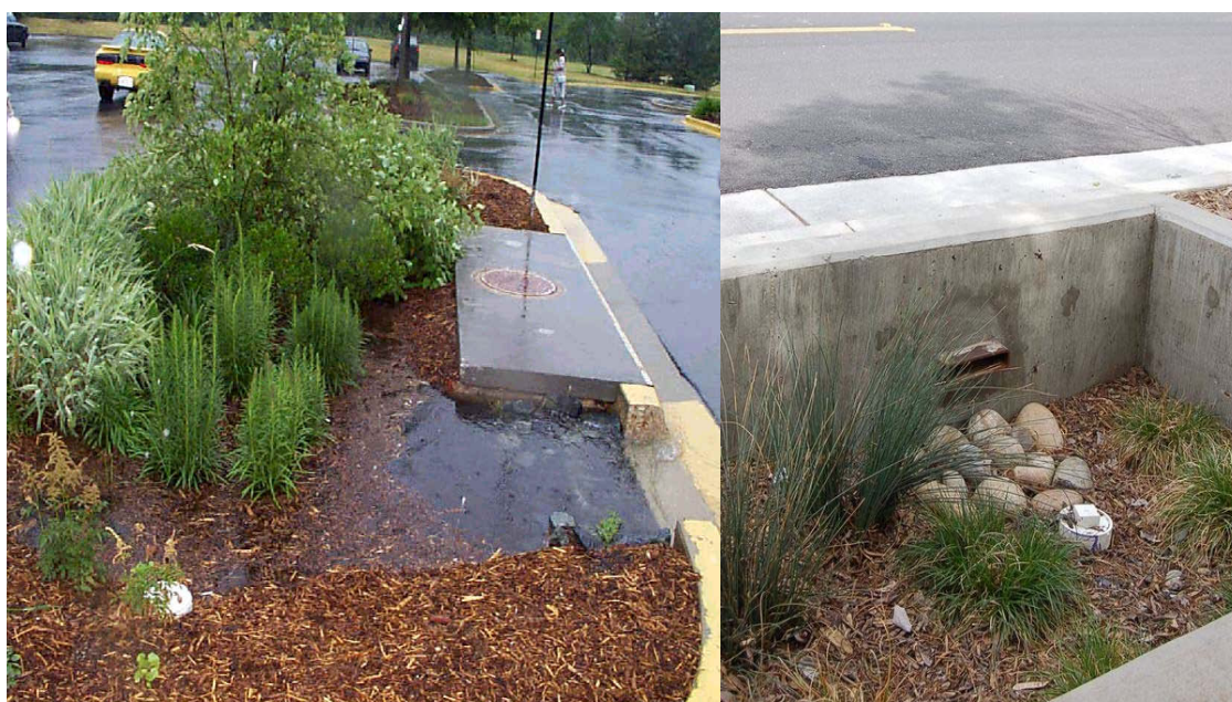
Immagini n° 42; n°43: Diverse tipologie di foratura del cordolo
