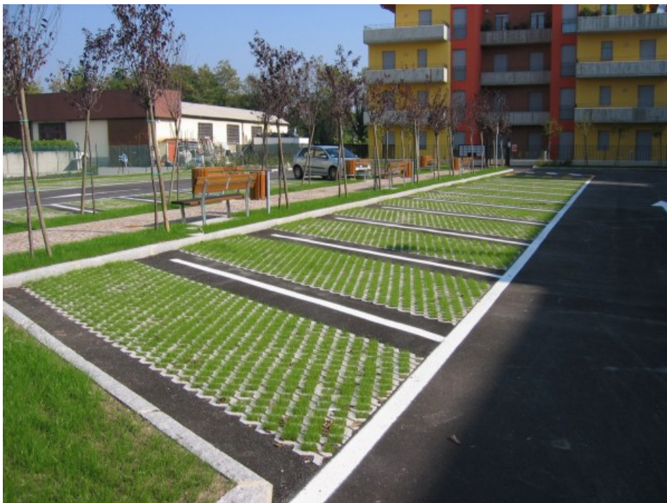
Immagine n°49: Esempio di grigliato inerbito in piazzole di sosta
