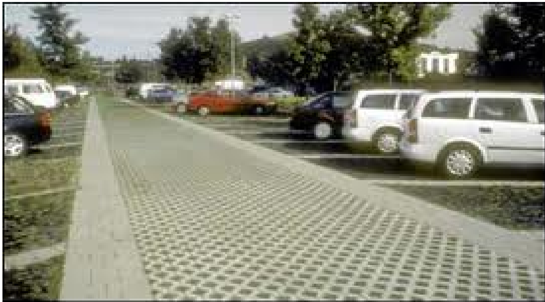
Immagine n°26: Altra metodologia costruttiva per la gestione meteorica
