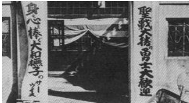
Entrata di una stazione di conforto. Questa foto di Autore sconosciuto è concesso in licenza da CC BY-SA
