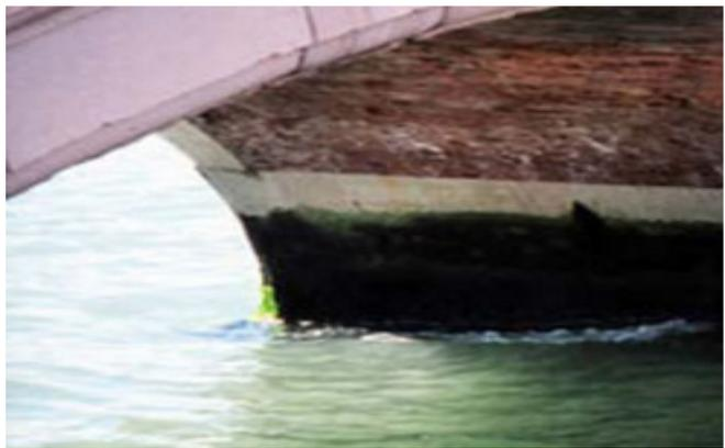
*Fig. 7-3 Umidità di risalita in un ponte lagunare a Venezia*
