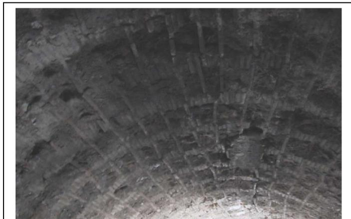
*Fig. 7-2 Fessure ad andamento longitudinale rispetto alla generatrice dell'arco*
