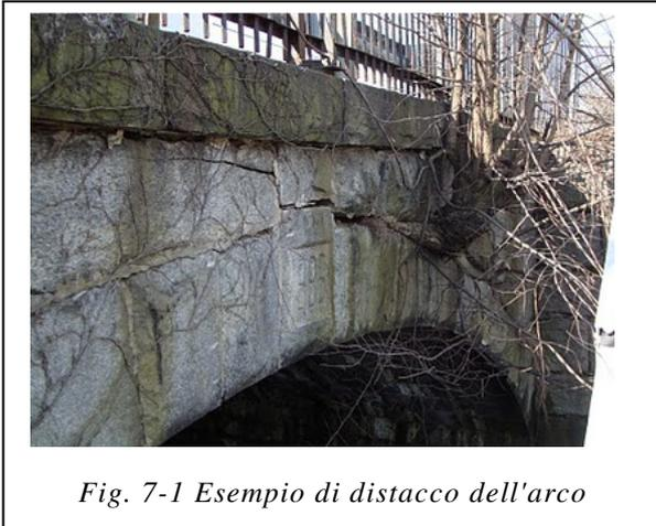
*Fig. 7-1 Esempio di distacco dell'arco*
