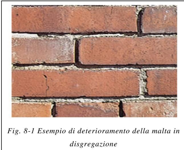
*Fig. 8-1 Esempio di deterioramento della malta in disgregazione*
