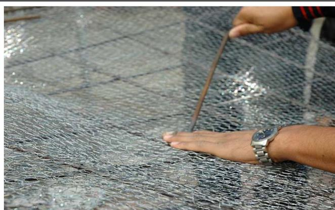
*Fig. 9-4 Trama della rete d'armatura per struttura in ferrocemento*
