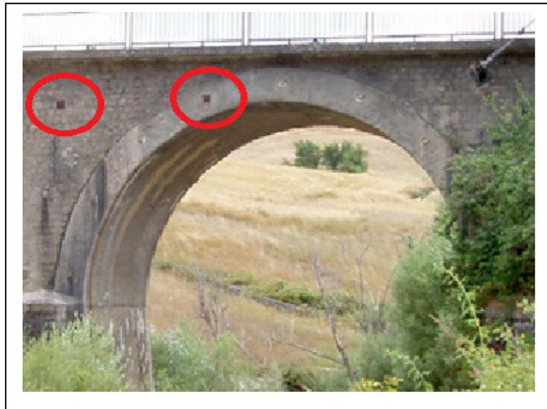
*Fig. 14-1 Ponte ad arco rinforzato con tiranti. In rosso evidenziate le piastre di ancoraggio*
