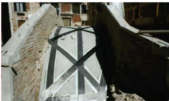
*Fig. 9-3 Applicazione di FRP all'estradosso dell'arco di un ponticello*
