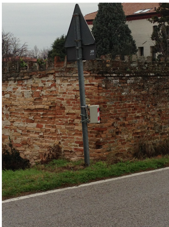
Fig. 3.4 - Wavetec: foto del dispositivo radar e posizione della corretta installazione.
