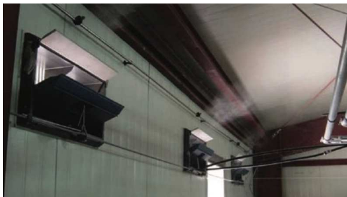
Figura 23. Sistema di raffreddamento con ugelli nebulizzatori.
