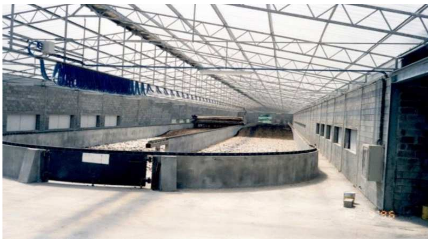
Figura 21. Compostaggio deiezioni zootecniche.
