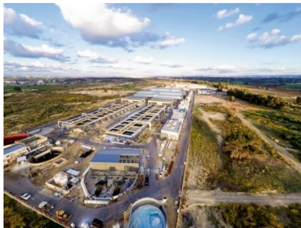
Figura 25: impianto di desalinizzazione di Sorek (Israele)
