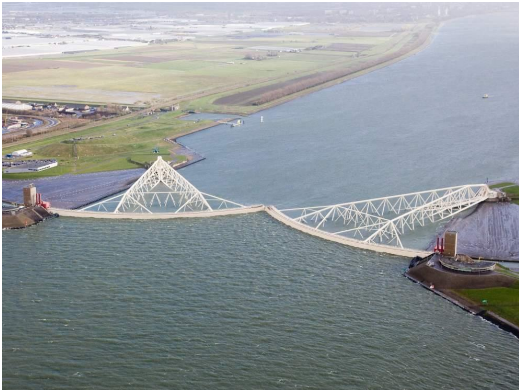
Figura 26: Il Maeslantkering è la più grande barriera architettonica finalizzata alla protezione dalle inondazioni costiere di Rotterdam e del suo porto
