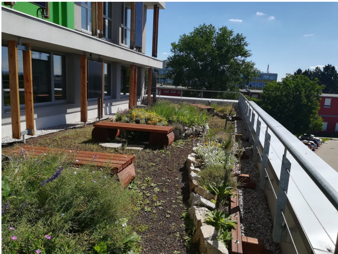
Figura 15 Porzione di tetto verde della facoltà di Scienze Ambientali della CZU
