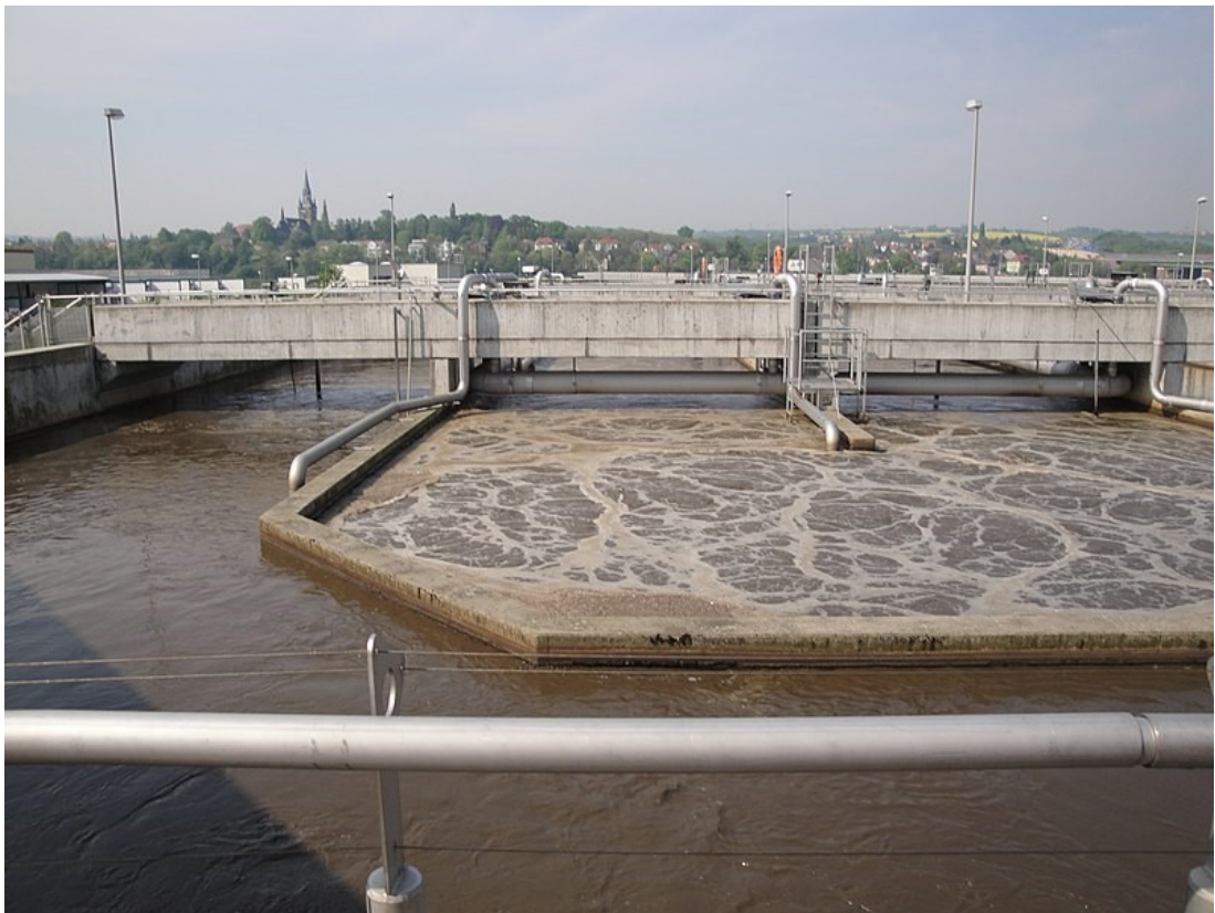
Figura 8 vasca dei fanghi di un trattamento delle acque reflue a Dresda ( www.susana.org )
