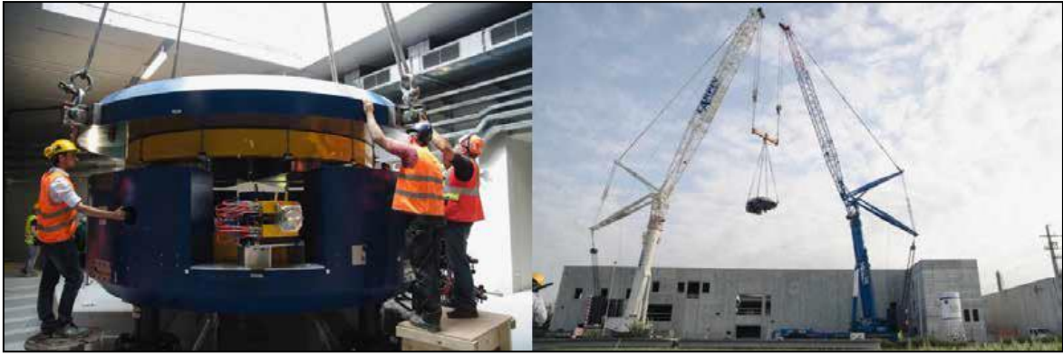
Figura 1.13: illustrazioni dei momenti di installazione del ciclotrone BEST 70p ai LNL. A destra è raffigurato l'edificio SPES, in fase di costruzione, al momento dell'arrivo dell'acceleratore primario.
