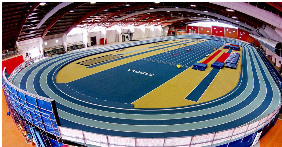
Figura 3 – Palaindoor di Padova, panoramica della pista dall'alto
