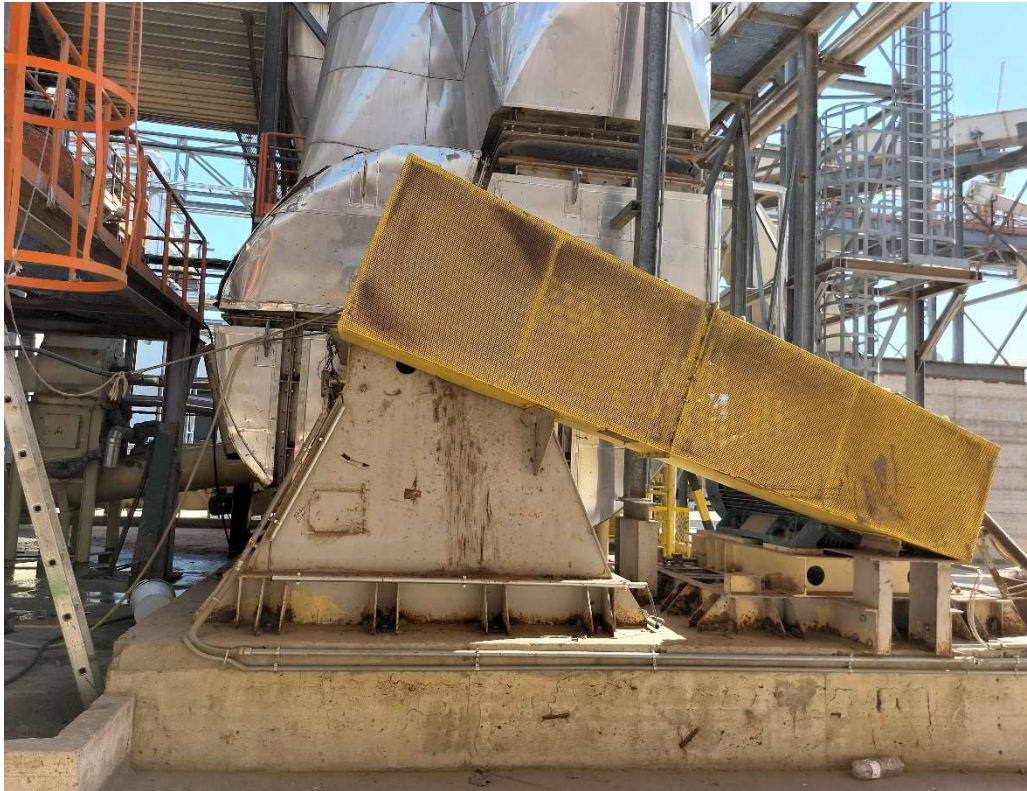
Figura 5.10 – Fotografia del ventilatore dell'essiccatoio, vista laterale. Come nell'immagine precedente, anche qui sono visibili l'involucro metallico che ospita il ventilatore e la gabbia metallica di protezione delle cinghie.
