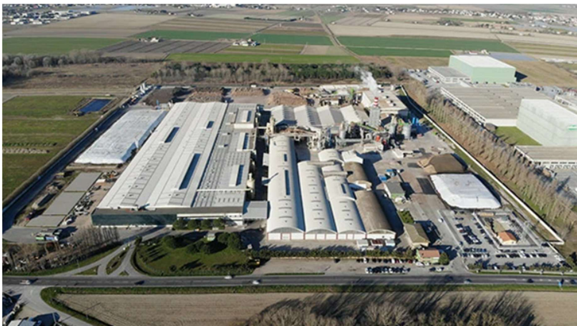
Figura 1.2 – Fotografia panoramica dello stabilimento produttivo Kastamonu Italia a Pomposa.
