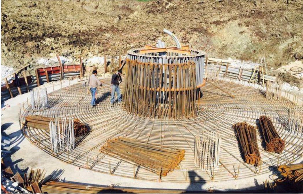
**Figura 3.3.** Fase di realizzazione della fondazione di un aerogeneratore
