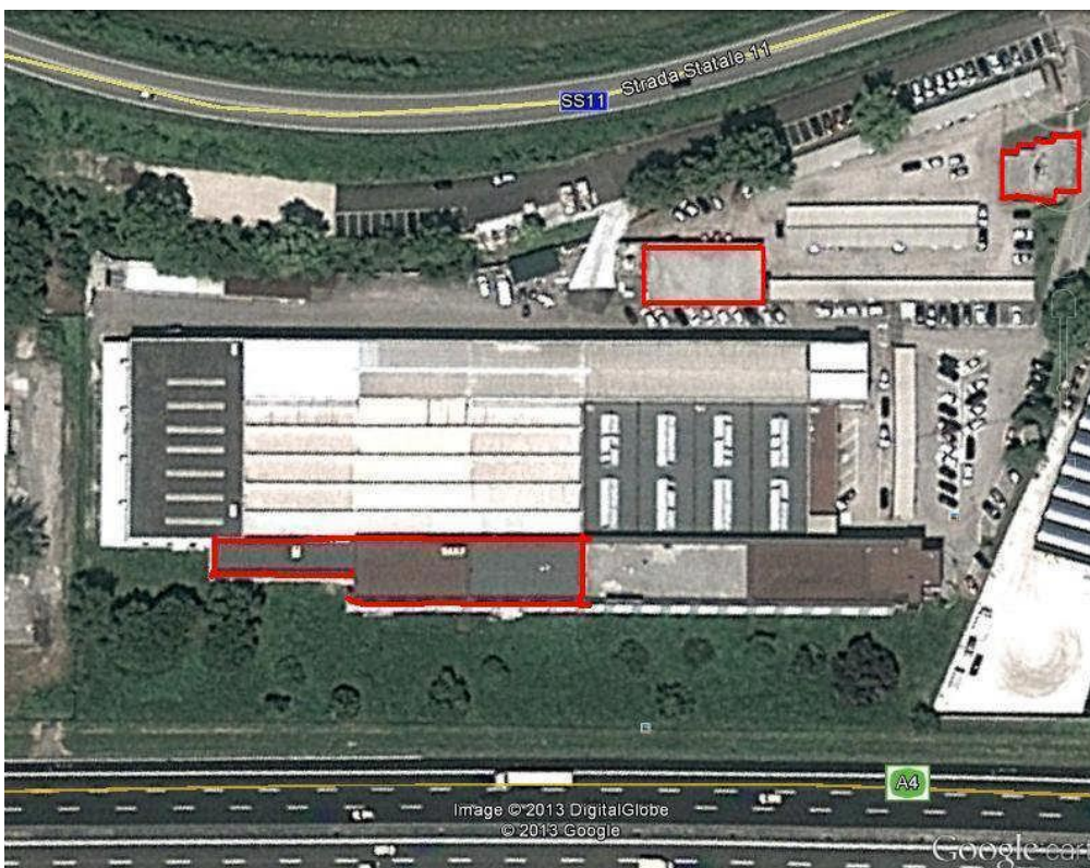
Figura 5.1: Veduta dell'impianto fotovoltaico di NIDEC ASI.
