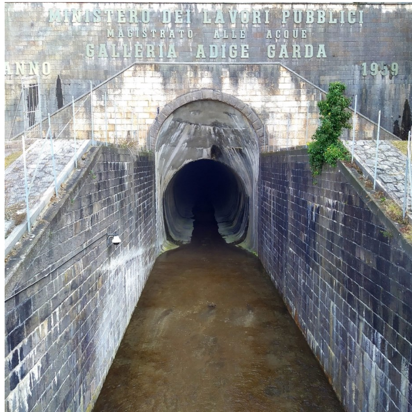
Figura 26: Sbocco della galleria sul lago di Garda
