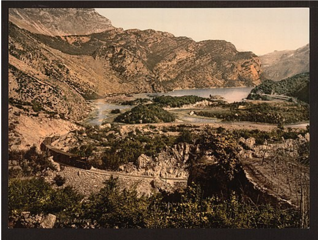
Figura 23: Lago di Loppio prima dei lavori di costruzione della galleria Adige Garda
