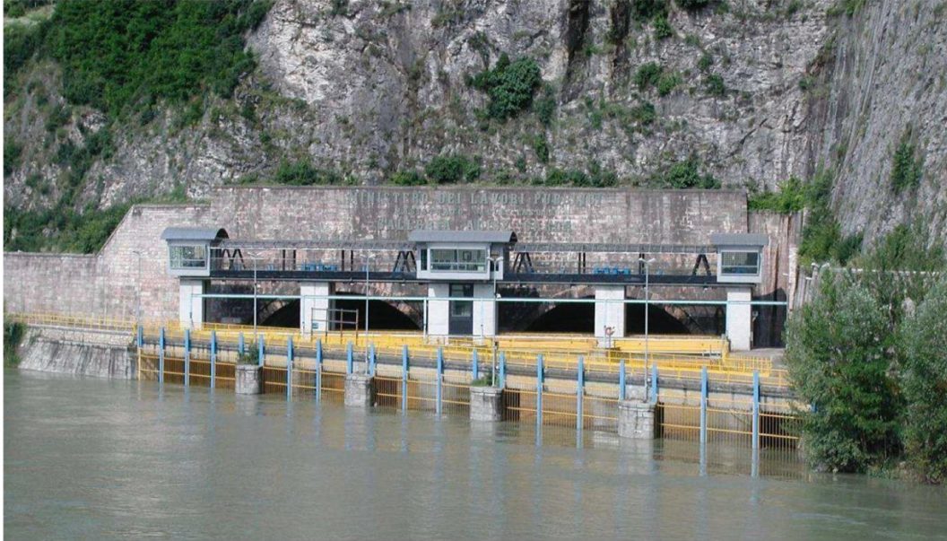
Figura 32: Le cinque luci di immissione presidiate da griglie all'imbocco della galleria a Mori.
