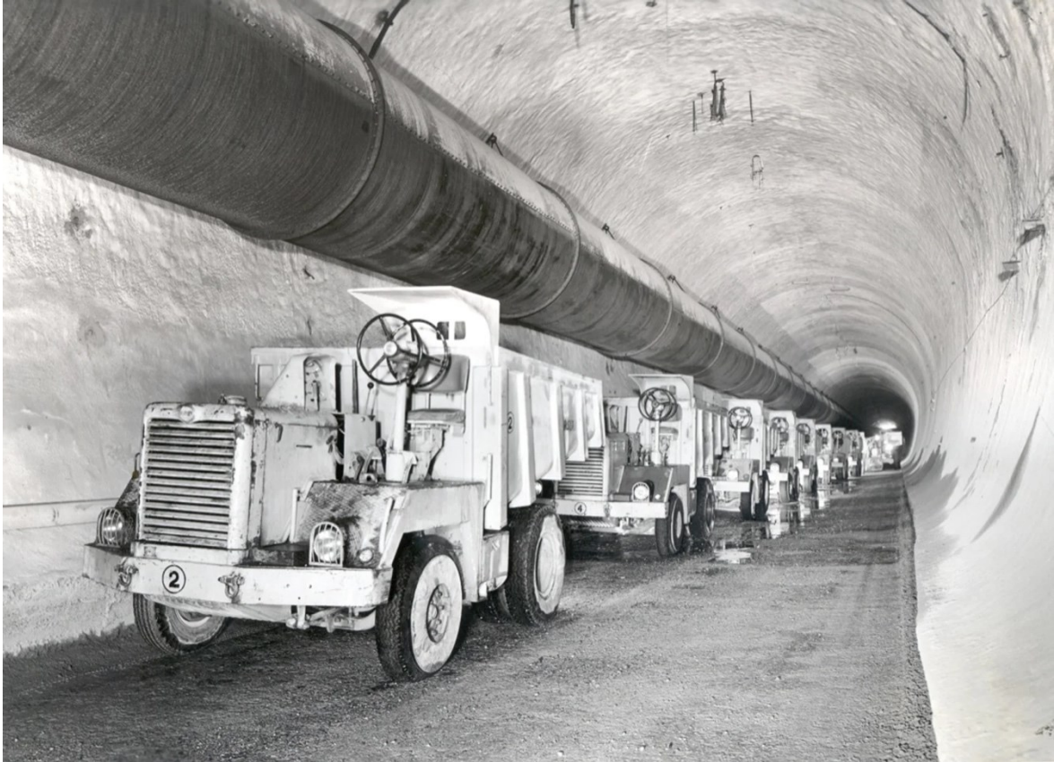
Figura 22: Inizio dei lavori di bonifica alla fine della guerra all'interno della galleria.
