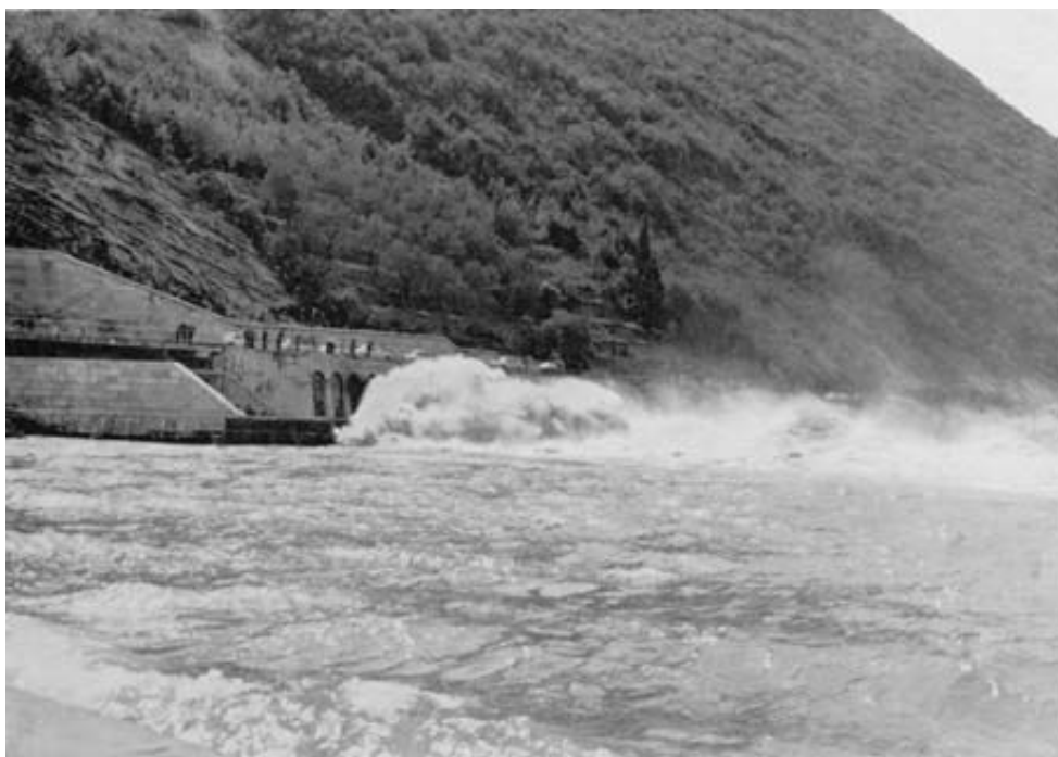
Figura 12: Scarico a Torbole della galleria Adige Garda nel 1965
