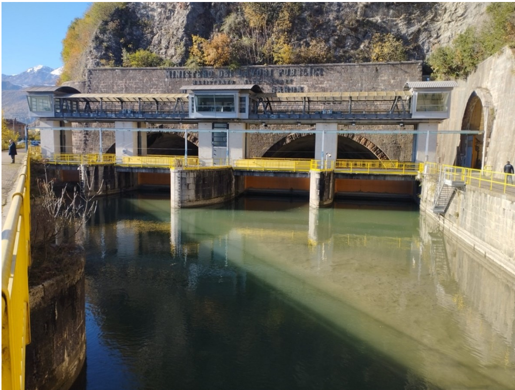
Figura 31: Luci di immissioni e relativi argani di sollevamento in corrispondenza dell'ingresso della galleria.
