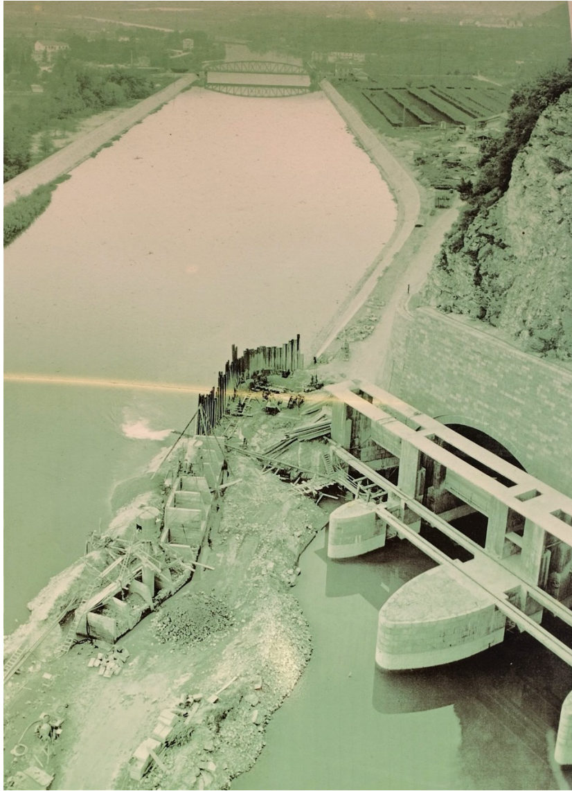
Figura 27: Lavori di realizzazione della galleria all'imbocca di quest'ultima.
