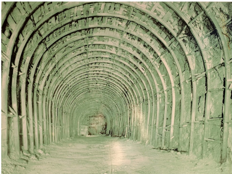
Figura 29: Lavori interni alla galleria in fase di realizzazione iniziale.
