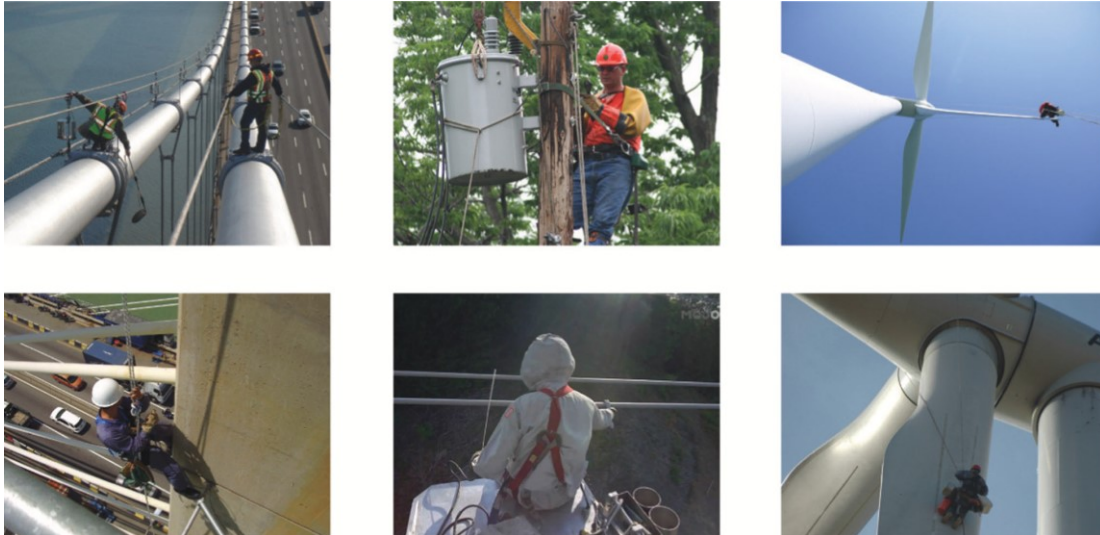
Figura 1. 1 Scenari applicativi per la manipolazione. Colonna di sinistra: ispezione di un ponte; colonna centrale: ispezione e fissaggio di linee elettriche ad alta tensione; colonna di destra: riparazione della pala del rotore di una turbina eolica [4].
