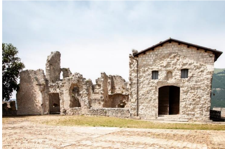
Figura 20: Veduta esterna a sinistra del Palazzo del Governatore e a destra della Chiesa di San Giacomo all'interno della terza piazza d'armi (Lorenzo Taccioli)
