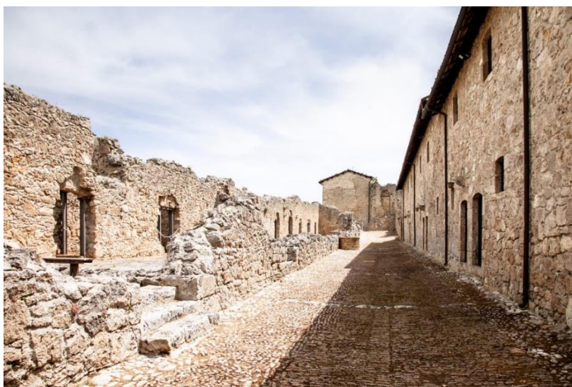
Figura 22: Veduta dal viale centrale degli alloggi dei soldati (Lorenza Taccioli)
