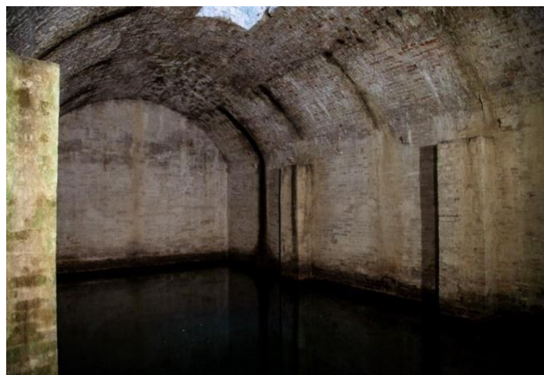
Figura 21: Foto interna della cisterna situata nella prima piazza d'armi (Lorenzo Taccioli)
