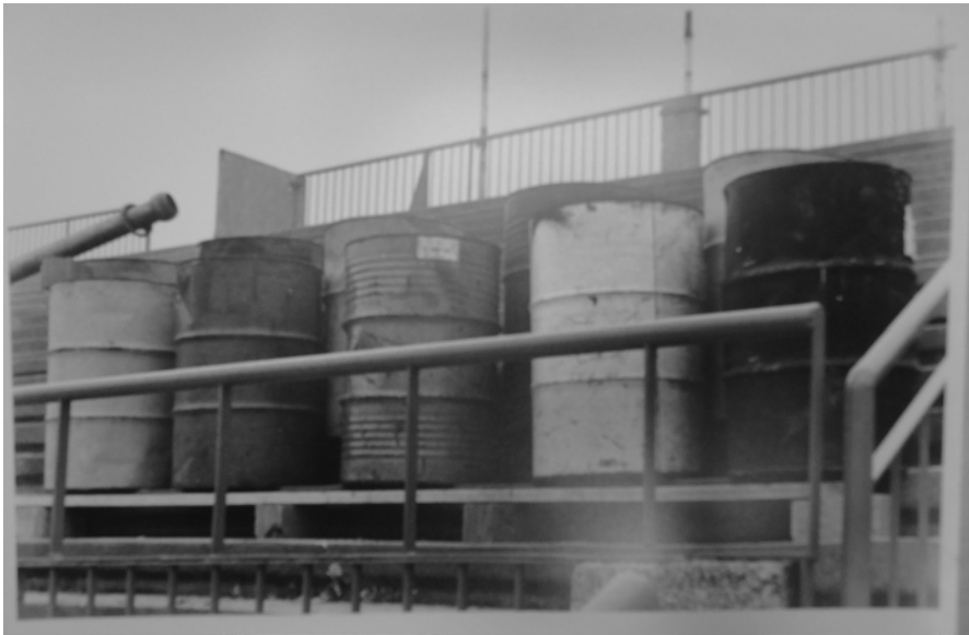
Figura 6.6.1: Sistema utilizzato per le prove di carico sui travetti della Tribuna Est. Fonte: [18]
