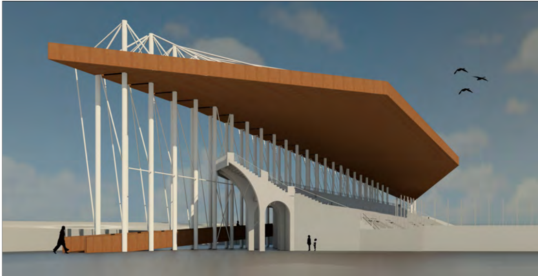
Figura 10.2.4: Soluzione strutturale 2 - Tiranti. Vista da Nord.
