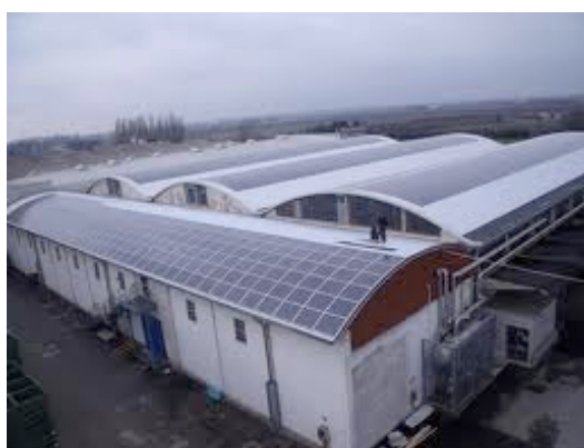
Figura 3.5 – Impianto fotovoltaico su capannone
