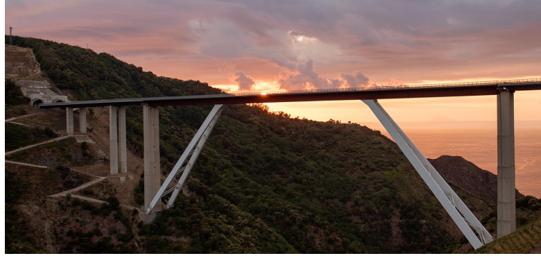
(a) Costruzione di viadotti («Viadotto Sfalassà», 2020).
