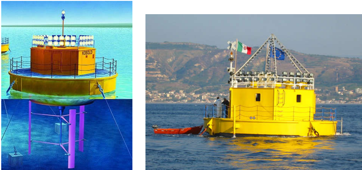
Figura 11: Rappresentazione schematica e foto del Kobold TEC
