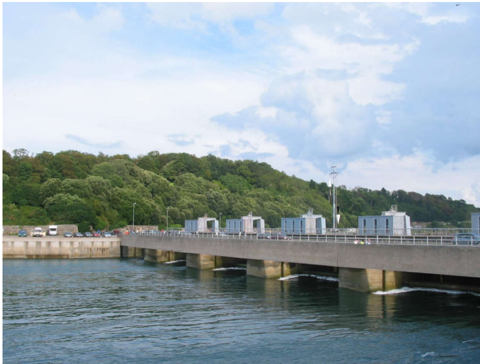
Figura 8: Sezione di un convertitore di energia tidal barrage (sopra) e foto del primo sbarramento di marea, e anche della seconda più grande centrale mareomotrice del mondo, "La Rance", situata in Francia (sotto)
