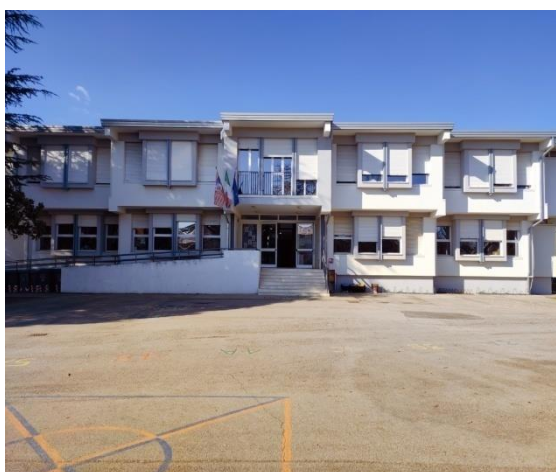
Figura 1: Foto facciata edificio Scuola Primaria "Masaccio"
