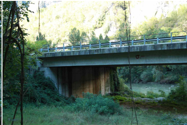
Figura 4.2.2.6.2: Vista della spalla lato Padova del viadotto
