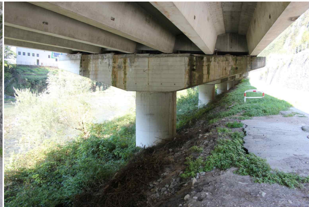
Figura 4.4.2.6.2: Vista delle pile del viadotto collocate in area pianeggiante
