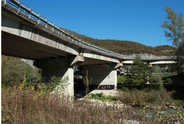
Figura 4.5.2.6.1: Vista dell'area in cui è localizzato il viadotto
