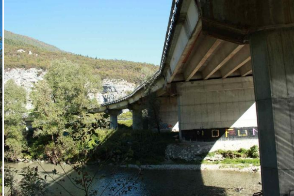
Figura 4.5.2.6.2: Vista di alcune pile del viadotto localizzate in area pianeggiante
