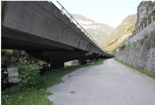
Figura 4.4.5.2.6.1: Vista dell'area attorno al viadotto
