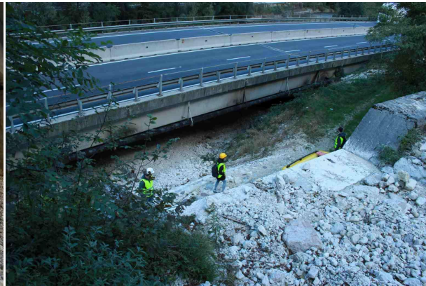
Figura 4.3.2.4.2: Vista della briglia localizzata subito a monte del viadotto
