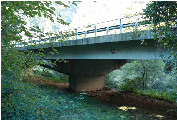
Figura 4.2.2.6.1: Vista dell'area sottostante una pila intermedia del viadotto
