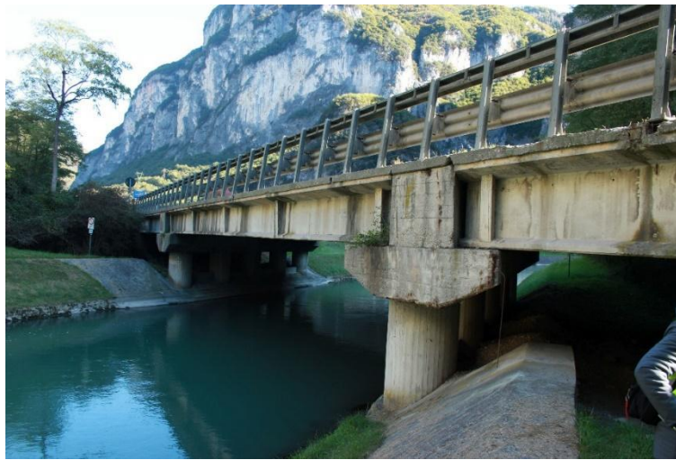
Figura 4.1.2.6.1: Vista dell'area sottostante il viadotto
